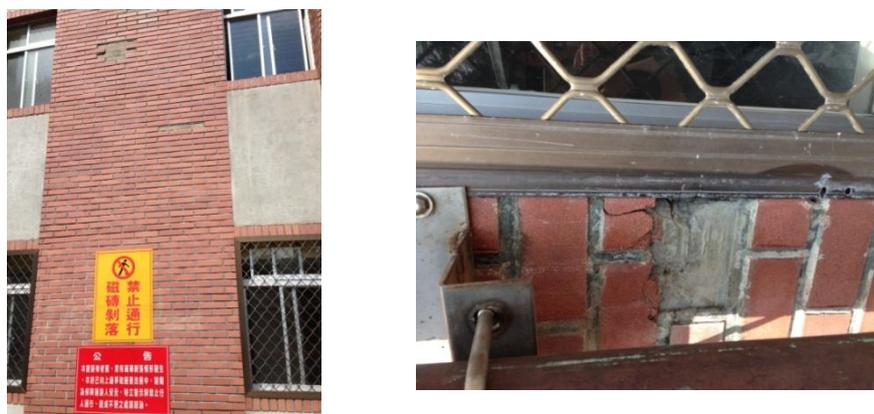
圖5-2-1 臺東縣政府文化處圖書館外牆磁磚剝落實景 I
