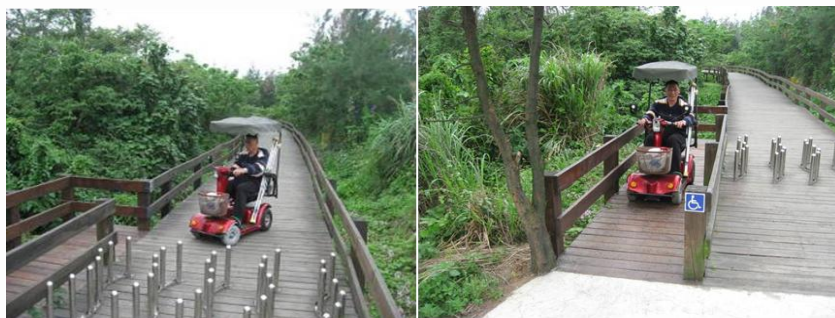
圖 30 首創之緩衝 S 型擾流柵檔麟山鼻自行車道無障礙設施
