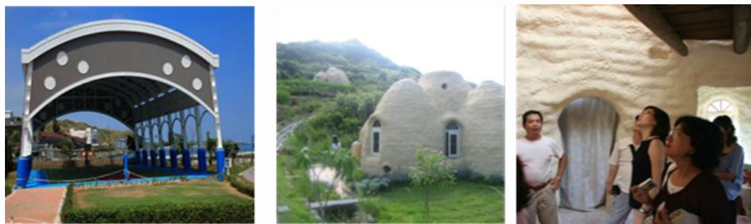
圖 77 石門國小風雨操場、金山農業資材室完工照及委員現勘圖
