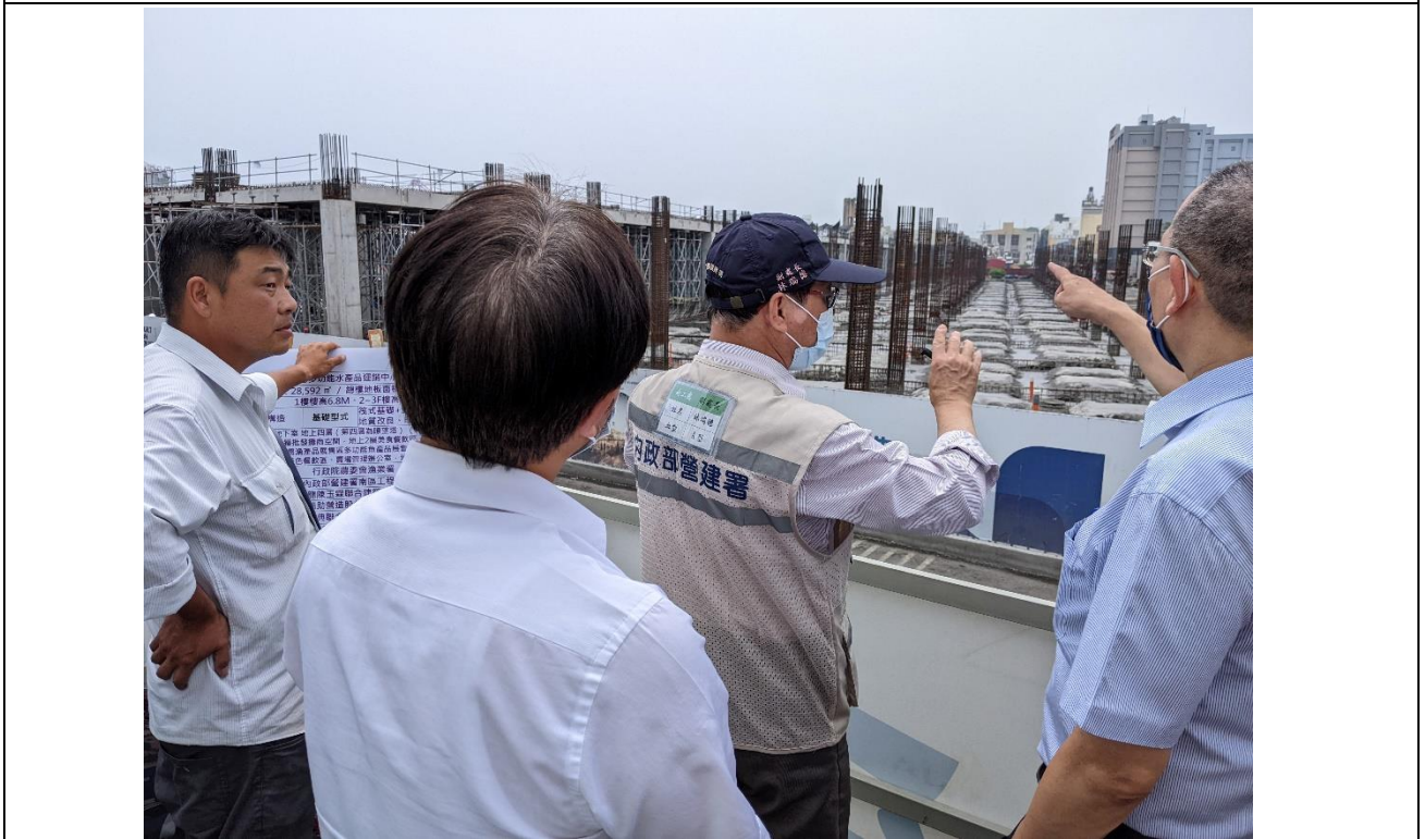
照片 2：實地查證多功能水產品運銷中心施工現場
