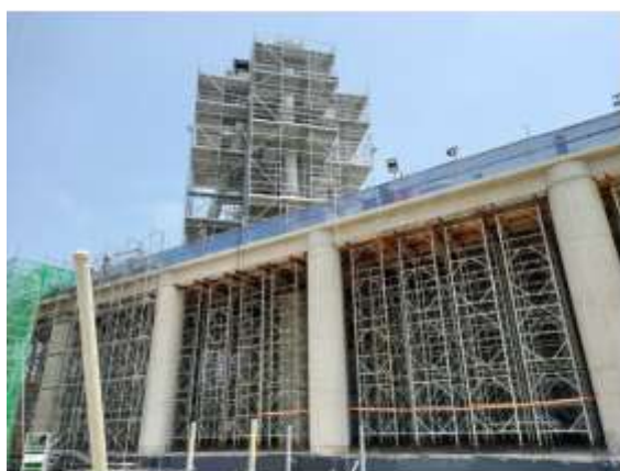
主體航廈土建工程(巨柱)
