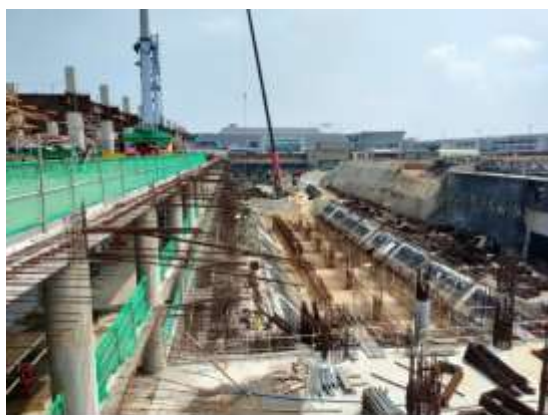
主體航廈土建工程
