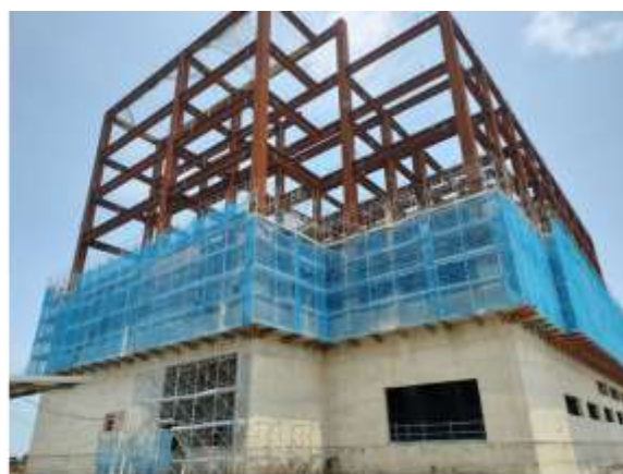
主體航廈公共設施工程(能源中心)
