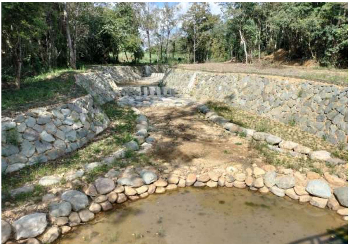
后湖橋上游野溪整治工程
