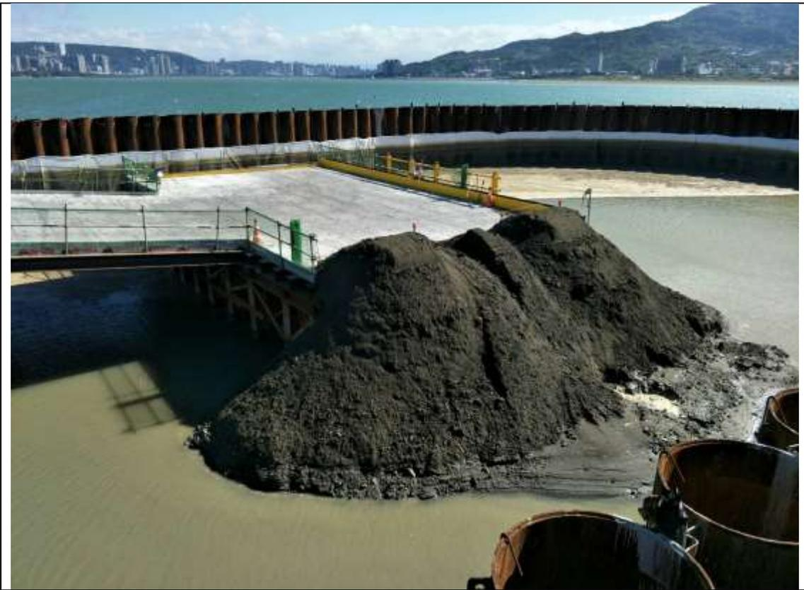
淡江大橋主橋段工程 P130 鋼管圍堰施工現況
