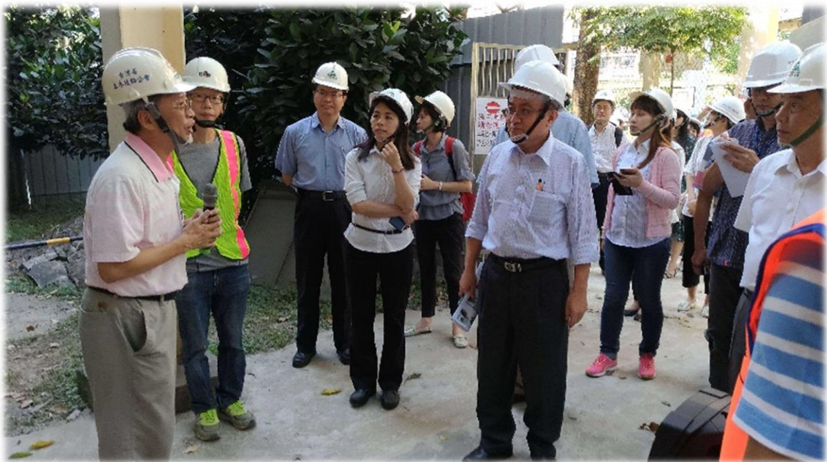
照片 4：新北市五華國小補強工程施工情形解說
