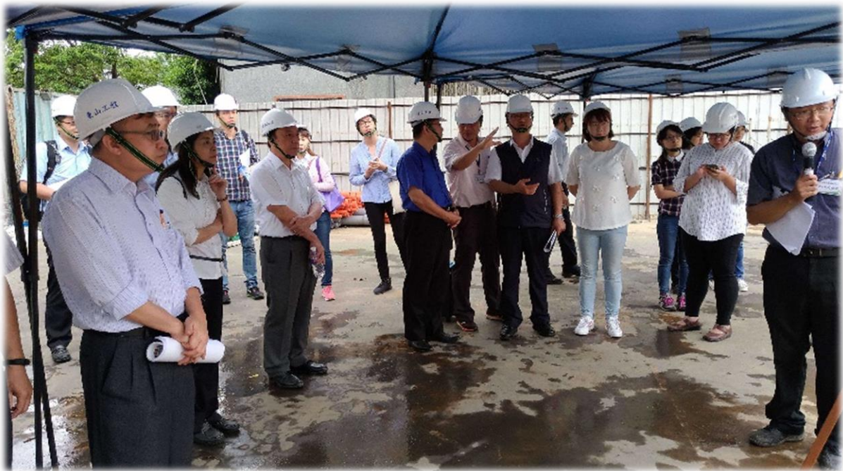
照片 3：新竹縣關西國小拆除重建工程施工情形解說
