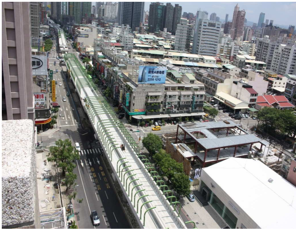
圖 6：捷運路線部分高架路段完成上部結構施工情形
