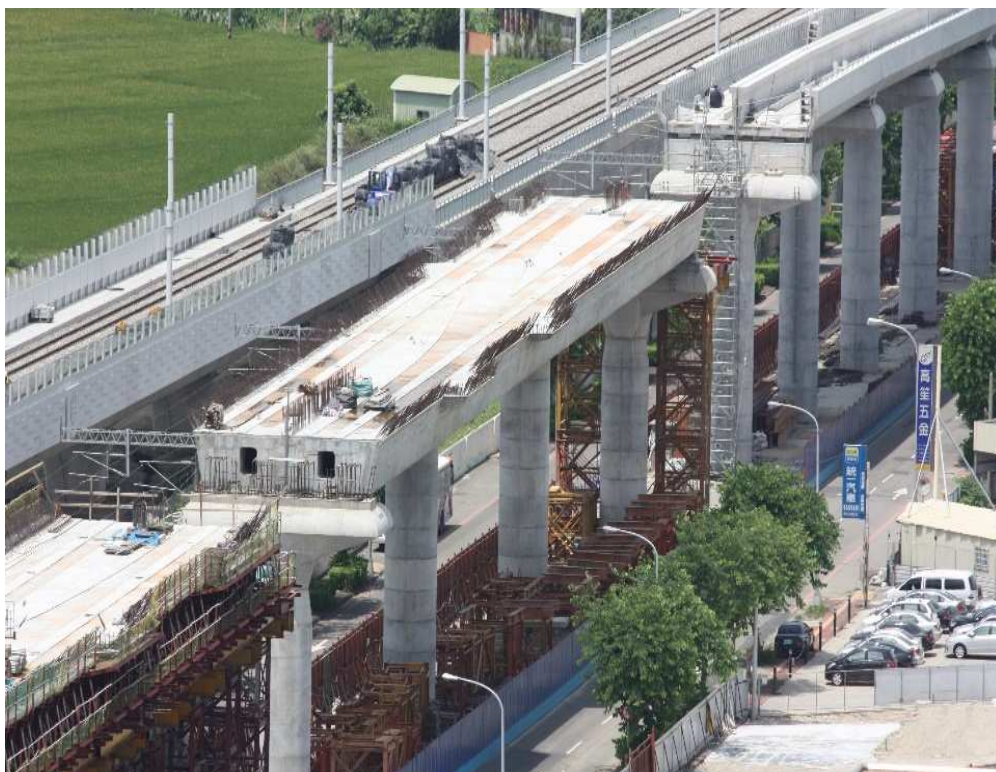
圖 5：CJ930 區段標場鑄 U 型梁(就地支撐)施工情形
