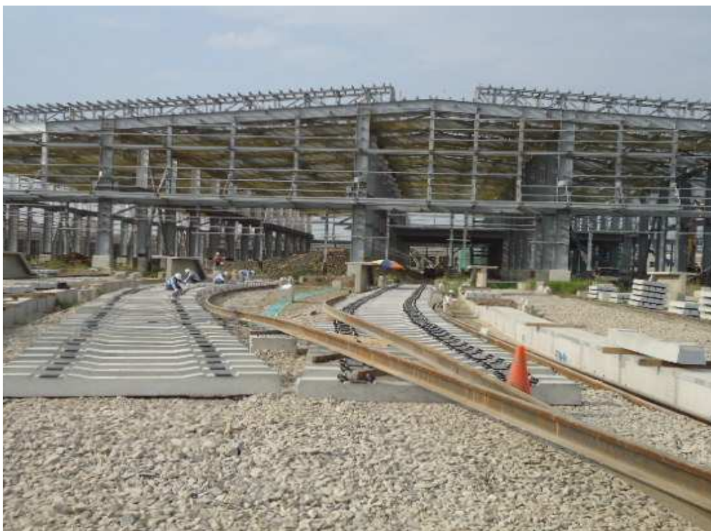
圖 3：CJ910 區段標北屯機廠之主維修廠現場施工情形
