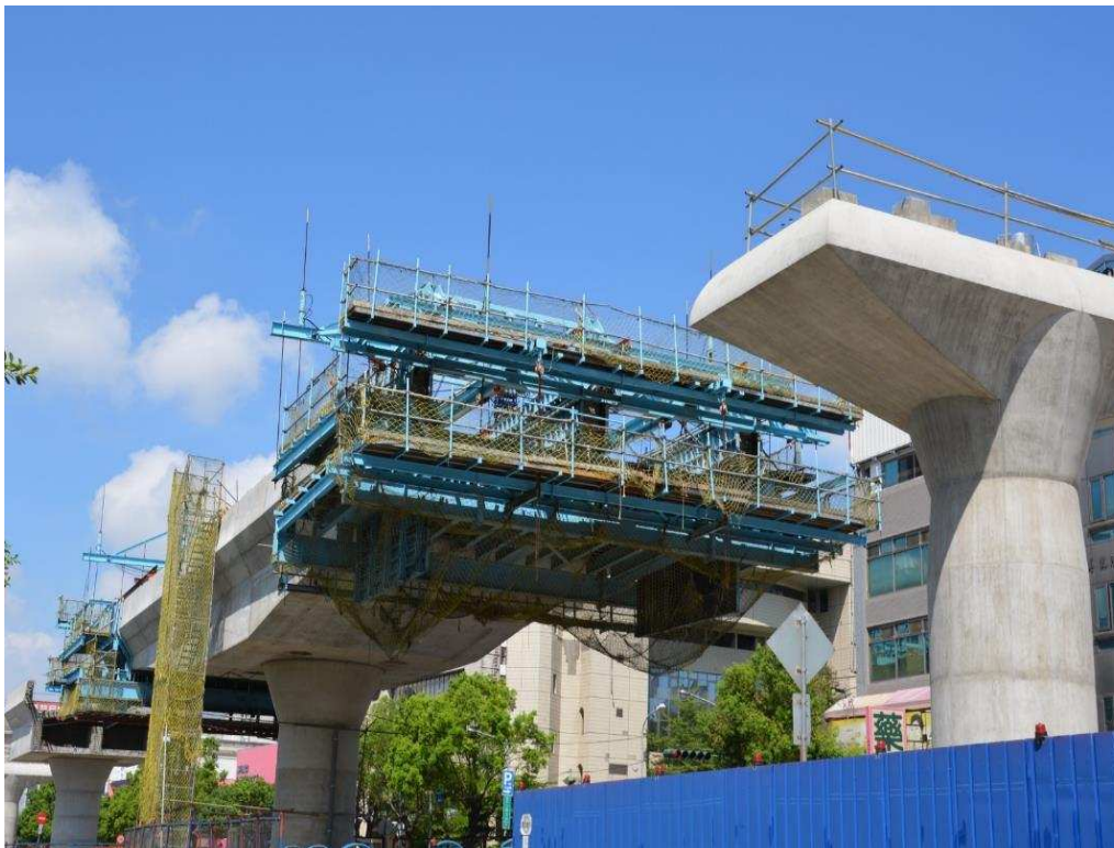
圖 4：CJ920 區段標採懸臂工法跨越通行道路施工情形
