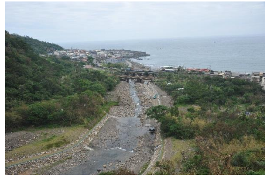
圖 8：頭城鎮大溪溪鐵路橋上游 治理第一、二期工程施工 情形
