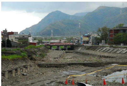
圖 9：南澳鄉南澳村武雲橋上游 清疏工程施工情形
