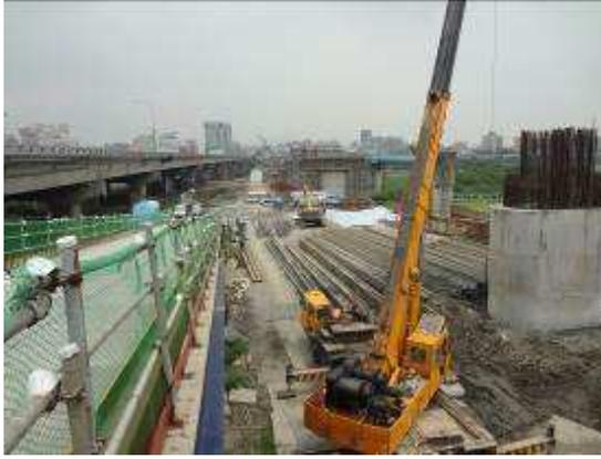
圖 7 跨大漢溪段高架橋梁之墩柱基礎
