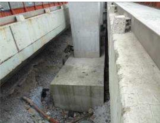
圖 5 捷運路線與台 64 線共線段之高架墩柱基礎施工現況(施工空間僅約 3 公尺寬)
