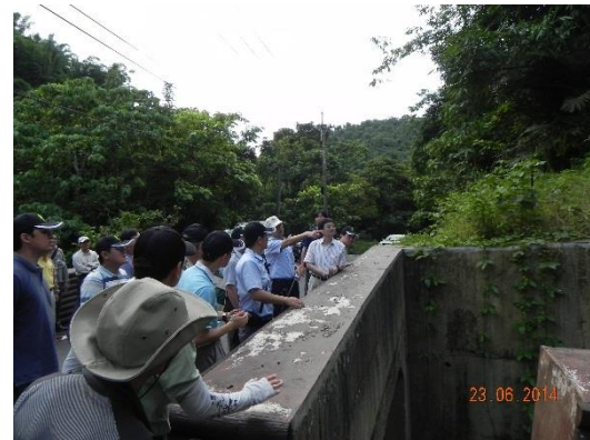
圖 4：實地訪查大埔區第 80 林班野溪整治工程
