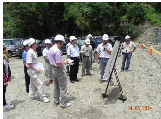
圖 6：玉井區第 69 林班亞美坑崩塌地整治三期實際施工現況
