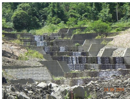
圖 10：亞美坑崩塌地整治一、二期成果及三期施工情形
