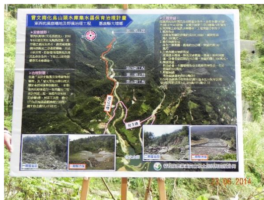
圖 8：東西坑溪崩塌地及野溪治理工程前後對照圖及成果
