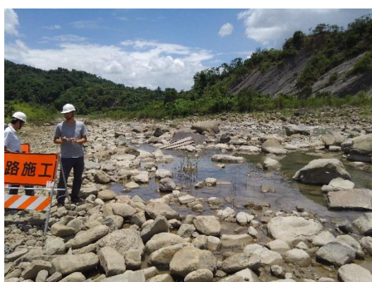
圖 11：仁耀橋下游護岸整治及關山第 12 號橋維護工程施工情況
