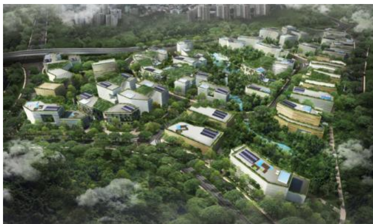
圖 20：新加坡 CleanTech Park 23
