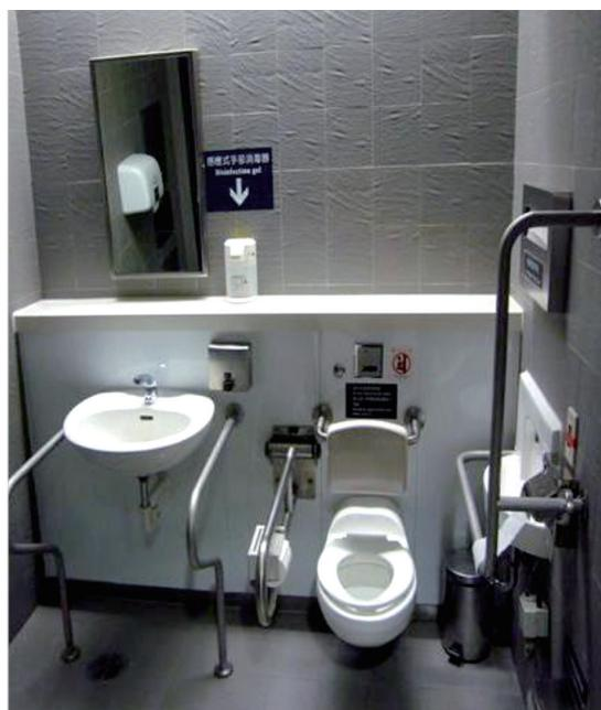
圖 2 廁所內馬桶、洗面盆旁邊加裝扶手及設置求助鈴
