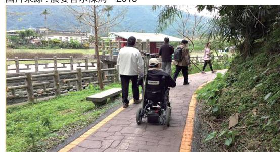
圖 10 碎石鋪面改成平整防滑鋪面
