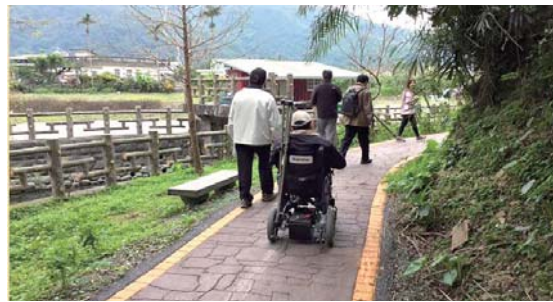
圖 10 碎石鋪面改成平整防滑鋪面
