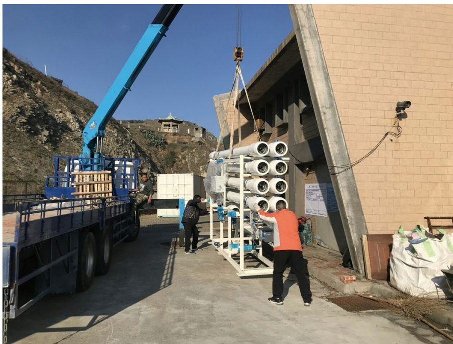
圖 15 東引海淡廠改善工程
