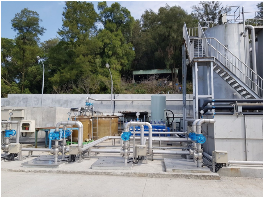
圖 14 后沃水庫水源淨水處理改善工程
