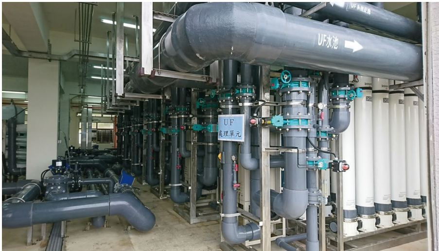
圖 10 大金門海水淡化廠一隅
