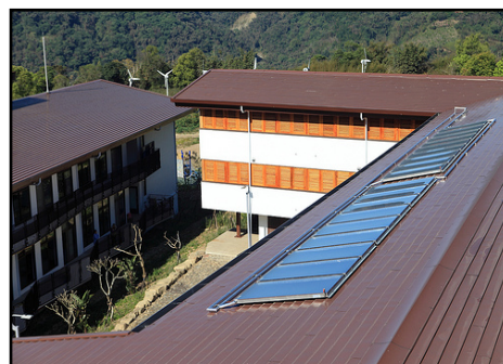
圖 3-3-3 太陽能熱能供電裝置示意圖
