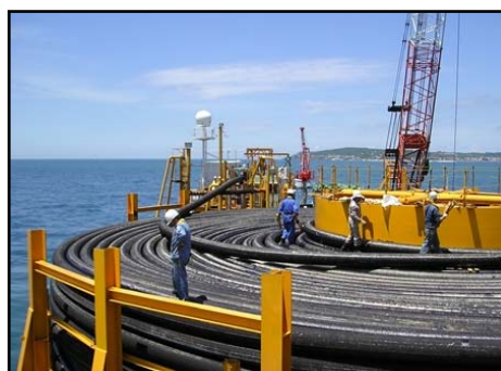
圖 2-7-1 海底自來水管工程
