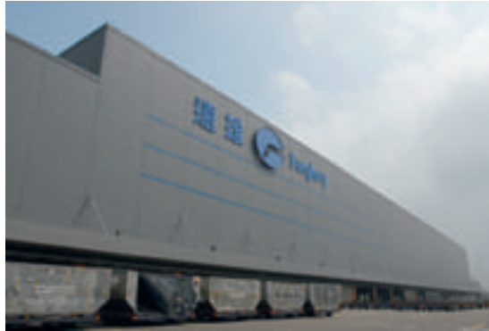
遠雄航空自由貿易港區從去年開始營運，完成後總建築面積預計可達35萬建坪。
