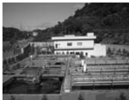
坪林污水處理廠
