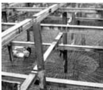
六塊厝污水處理廠池槽施工
