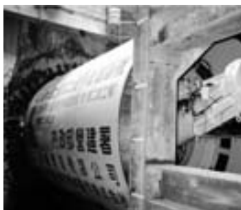
污水管線潛盾機施工
