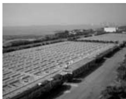
八里污水處理廠初沉池
