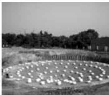
鳳山溪污水處理廠池槽施工
