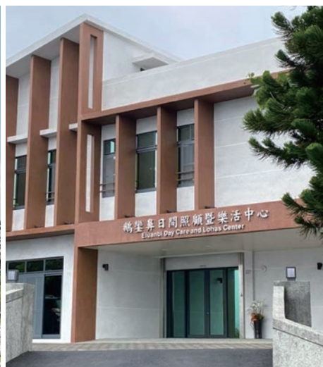
城鄉建設——整建長照衛福據點 （鵝鑾鼻日間照顧中心）
