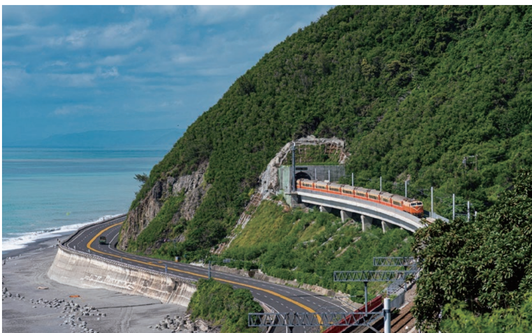
南迴鐵路電氣化
