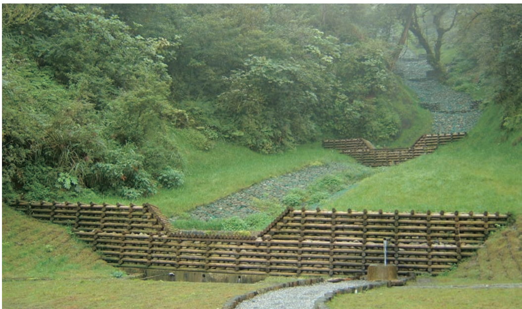
國產材多元利用——柳杉運用於森林土木工程
