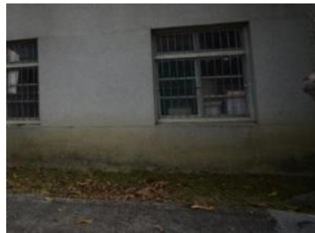
以街廓編碼 A-B2-12 乙種平房為例—建物背立面柴燒區域牆體汙損風化、白華
