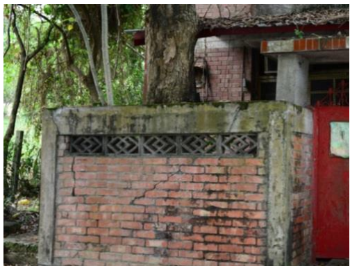
以街廓編碼 A-B4-5 乙種樓房為例—圍牆開裂、砌磚白華汙損、混凝土面層風化青苔
