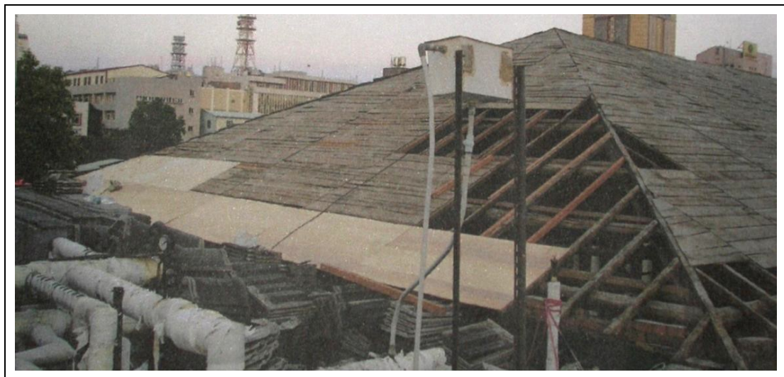
圖 6-9 新舊屋面板集中鋪設 (資料來源：本計畫整理)
