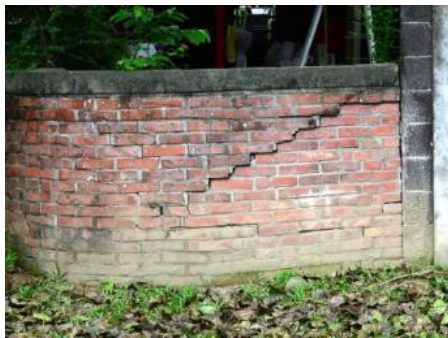
以街廓編碼 A-B4-5 乙種樓房為例—圍牆開裂、砌磚白華汙損、混凝土面層風化青苔
