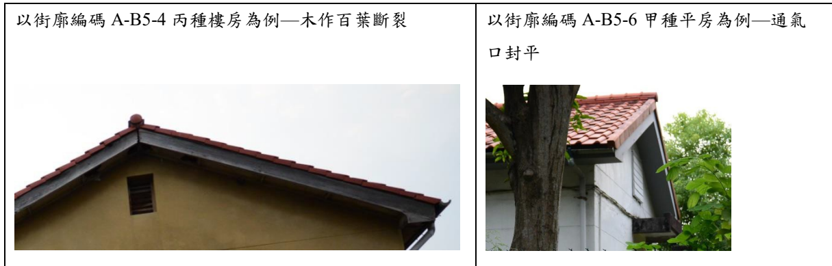
圖 4-68 山牆通氣孔損壞狀況—機能性 (資料來源：本計畫整理)
