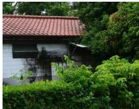
以街廓編碼 A-B2-12 乙種平房為例—建物背立面柴燒區域牆體汙損風化、白華
