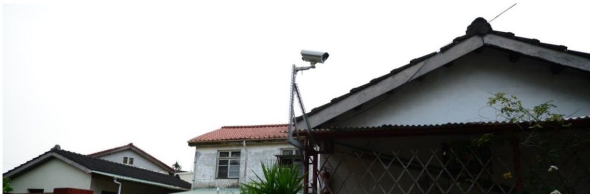
圖 4- 61 屋瓦現況—外觀性 (資料來源：本計畫整理)
