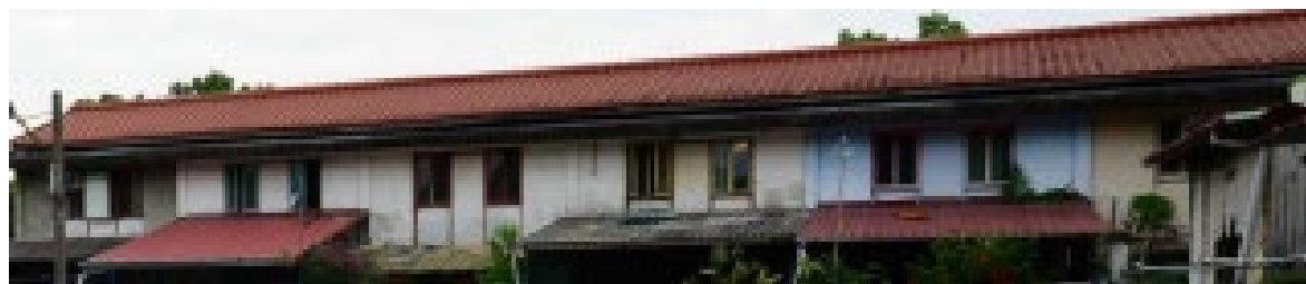
圖 4- 70 門扇損壞狀況—外觀性 (資料來源：本計畫整理)
