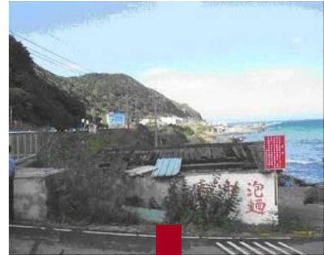
台2線違建拆除
