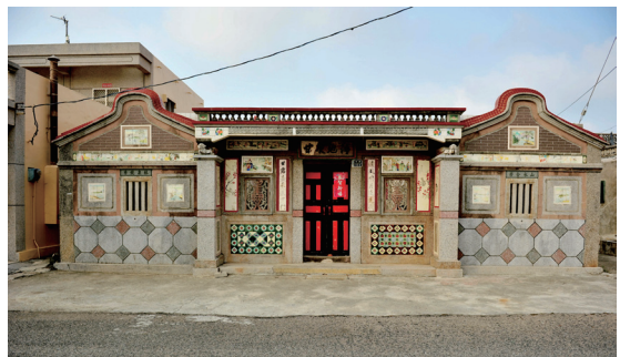
圖 7 南寮古厝，以玄武岩、咕咕石為建材的傳統閩南式建築，斑駁的牆壁訴說著過去澎湖人生活的歷史與故事
