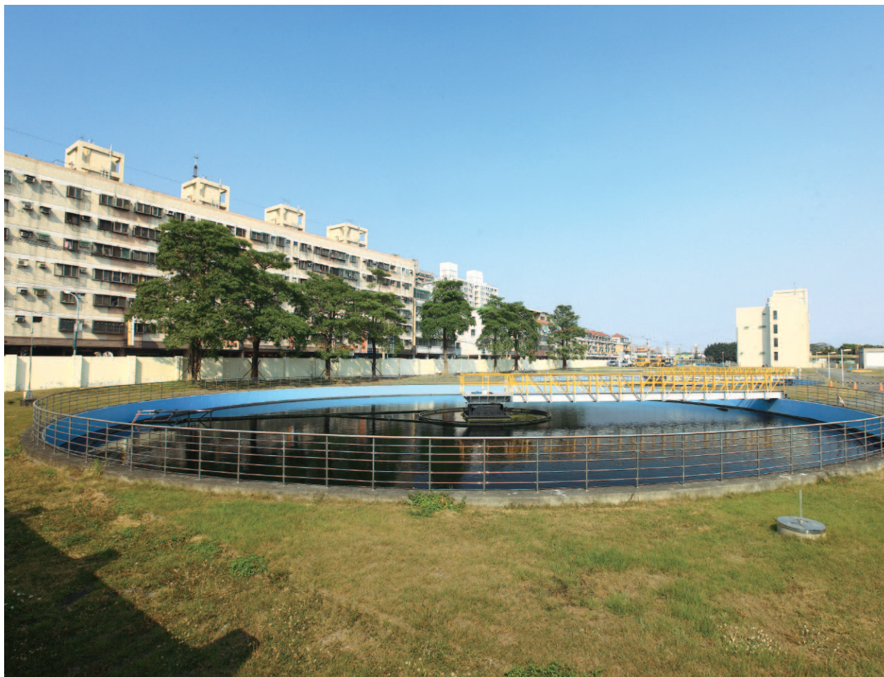
福田水資源回收中心，主要功能是處理生活污水，讓水再生利用。
