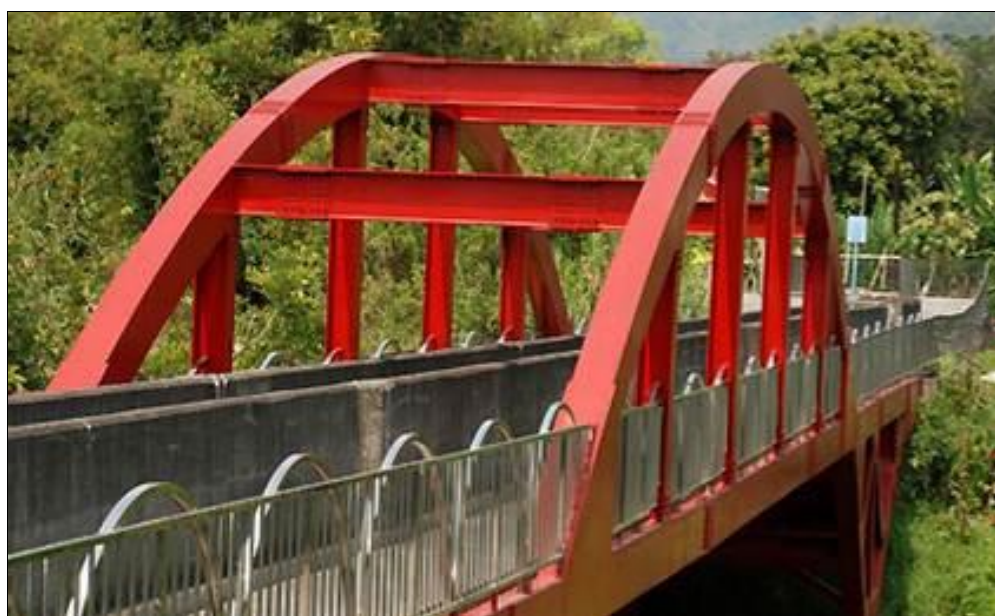
圖 4-7 中興新村成源圳及水橋 (圖片來源：成源圳中興新村水橋碑記，簡榮聰，2008. 12。)
