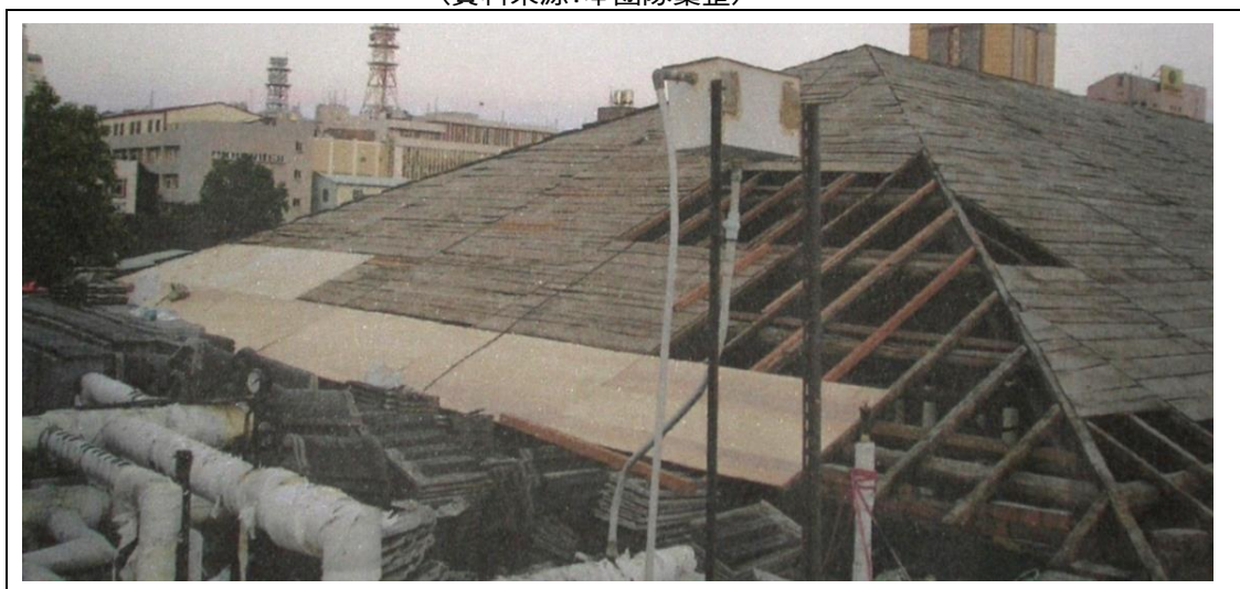
圖 6-20 新舊屋面板集中鋪設 (資料來源:本團隊彙整)
