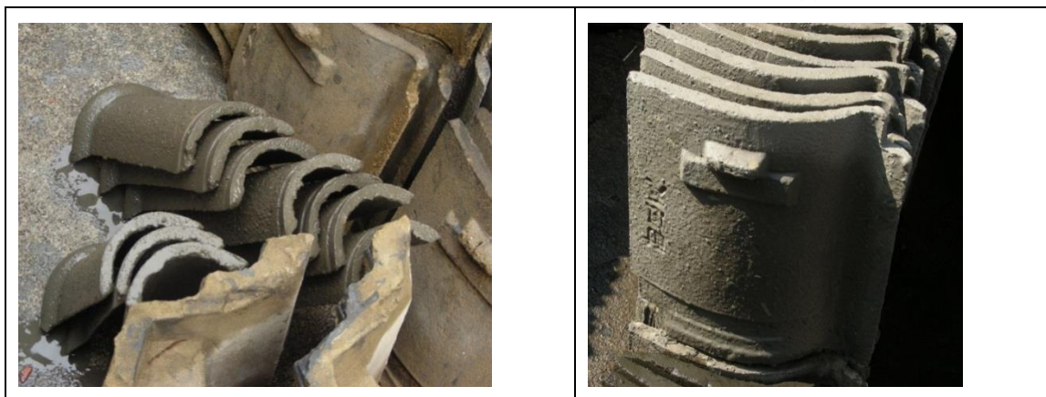
圖 6-19 將修繕或續用之舊料與更換之新料分開集中鋪設 (資料來源:本團隊彙整)
