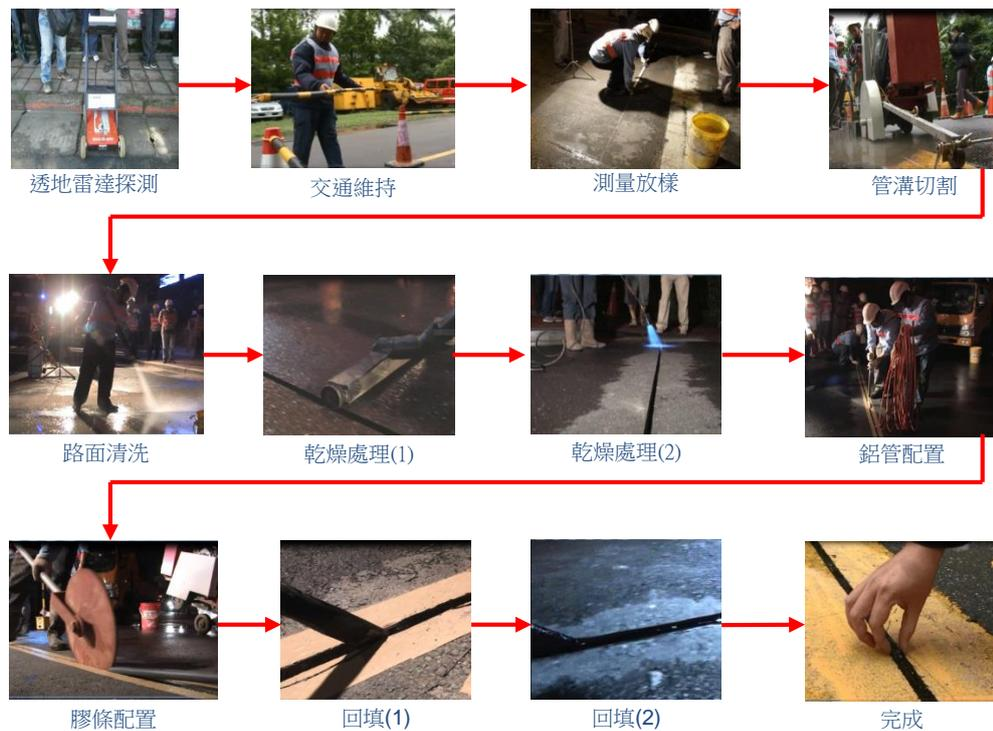
圖 2 微管溝工法施工步驟
