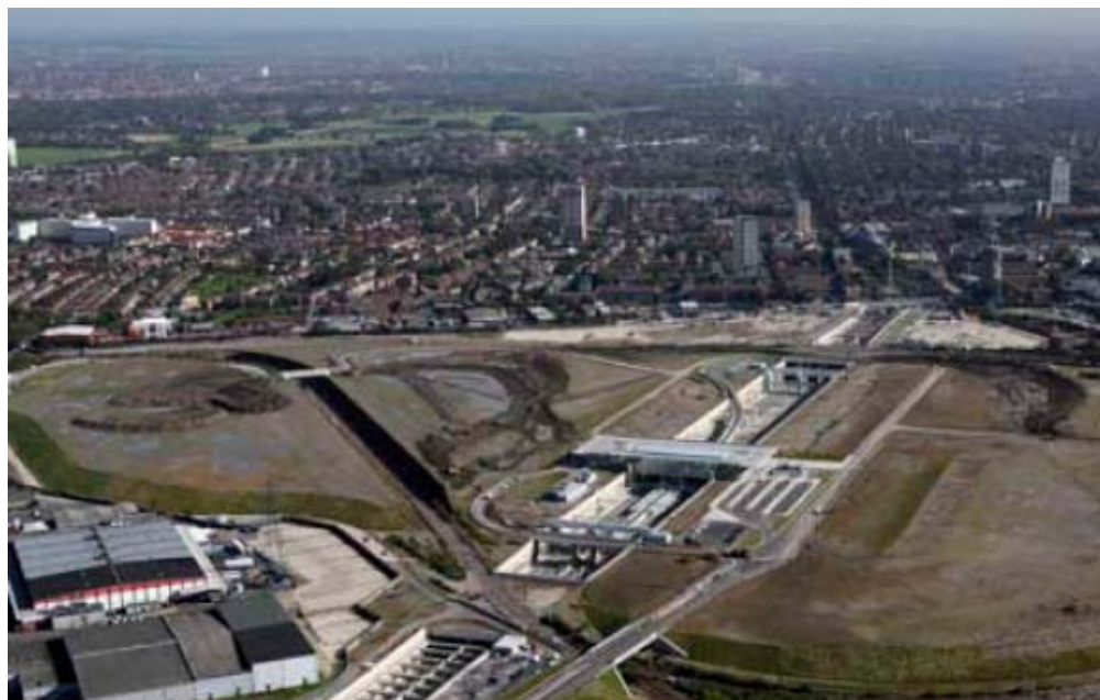
圖 47 3-18 基地現況照片
