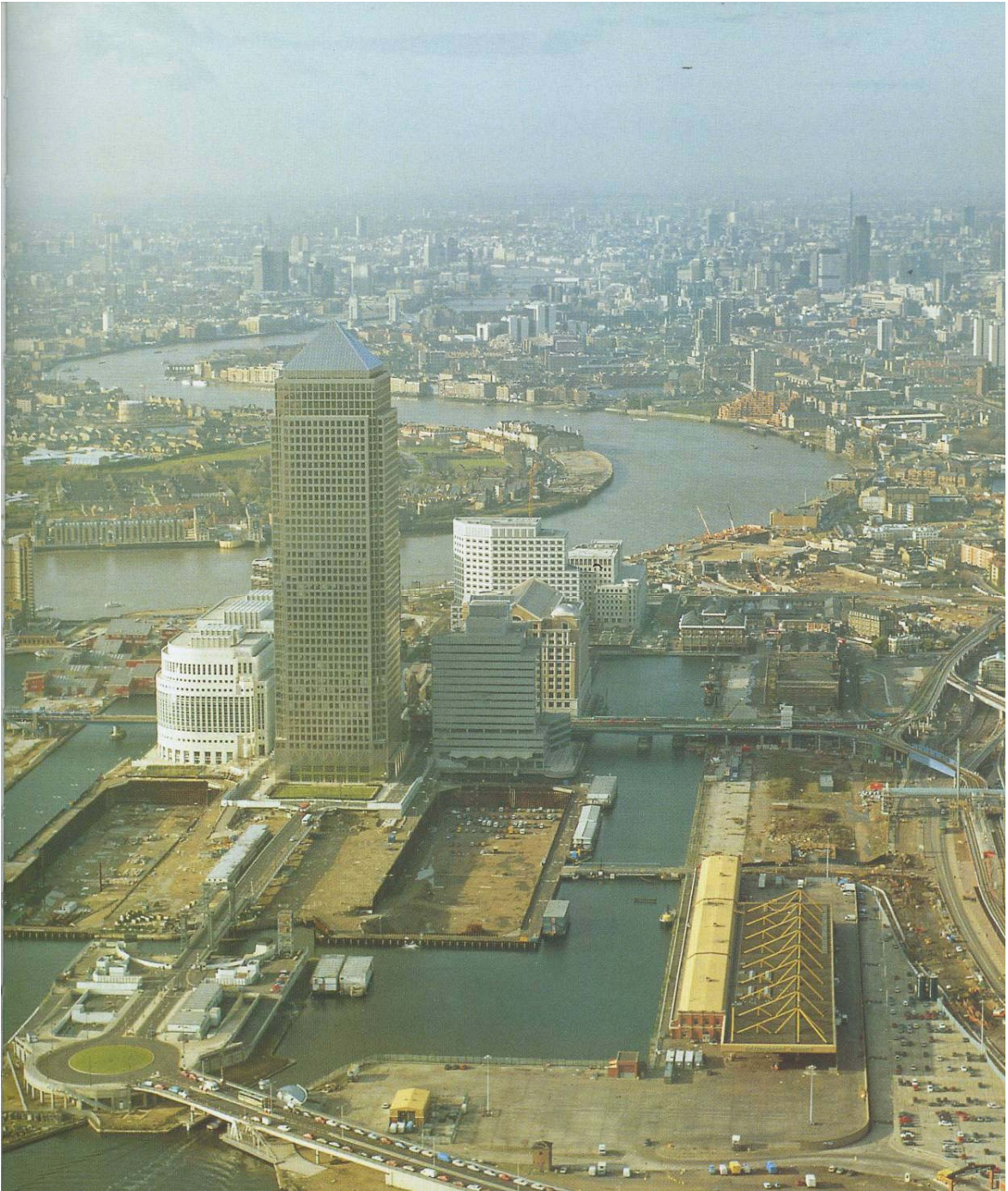
圖 55 3-24 第一階段工程完工時
