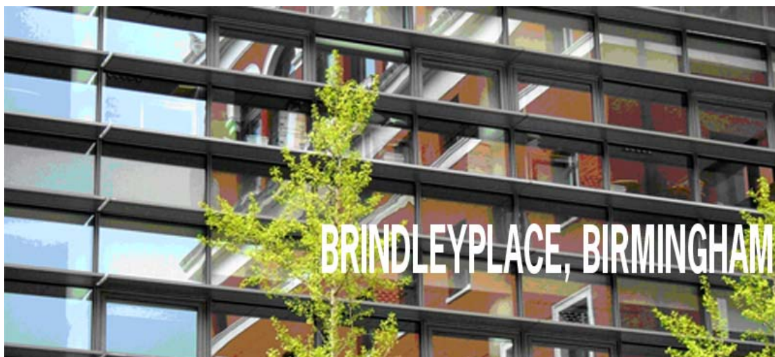
圖 70 3-35 Brindleyplace 更新後辦公大樓一角
