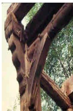
右圖為我家族擁有的古老水上城堡，在修復的過程中，過去三個世代以來不適當的建築設施將被去除，因為“現代化”的材料已危及損害結構本體，所以改採較佳的材料例如潤滑木料的油脂和填充內部的黏土，目前城堡已屹立好一段時間。這些百年以上古老的例子顯示出建造房舍時的準則“綠建築式設計及應用綠建材”。
