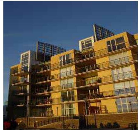
圖 5-6 太陽能熱水加熱板
