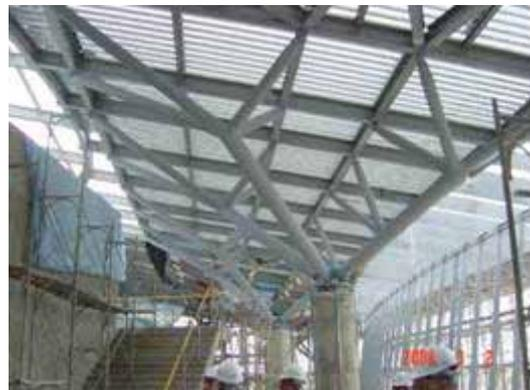
圖 32 入口大廳的樹狀結構
