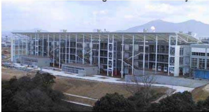
圖 5-27 突出於建築本體上的熱浮力通風煙囪(Stack Effect)
