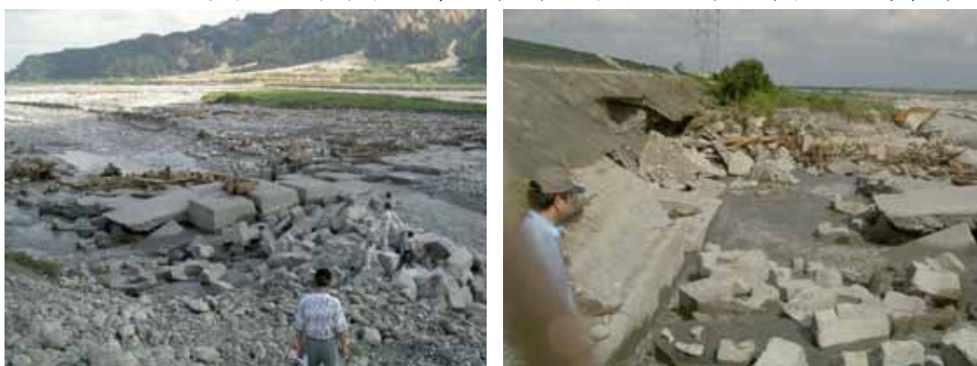
照片 43 大安溪土城堤防橋樑下游固床工（左），固床工與堤防交接面（右）
