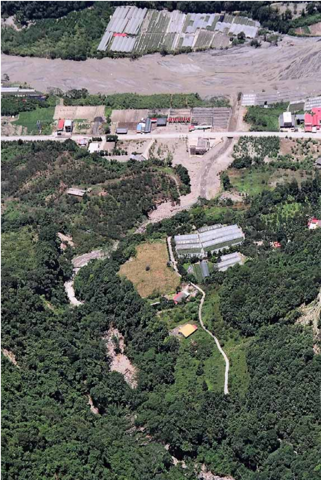
南投 004 土石流潛勢溪流下游沖積扇，沖積扇正中央為加油站。因下移土砂粒徑較小，因此加油站以及南山橋僅被掩埋，並未直接被破壞。
