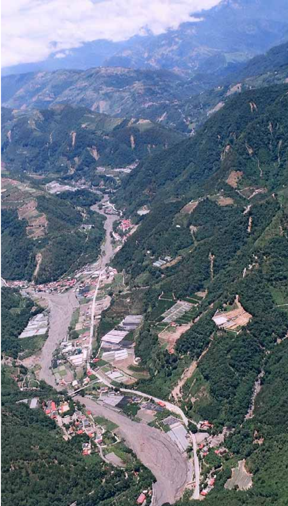
眉溪(縱貫照片中央)與南山溪(照片左側中央)交會處。台 14 線即沿眉溪闢建，南豐村 5,6,7 鄰即位處於南山溪。
