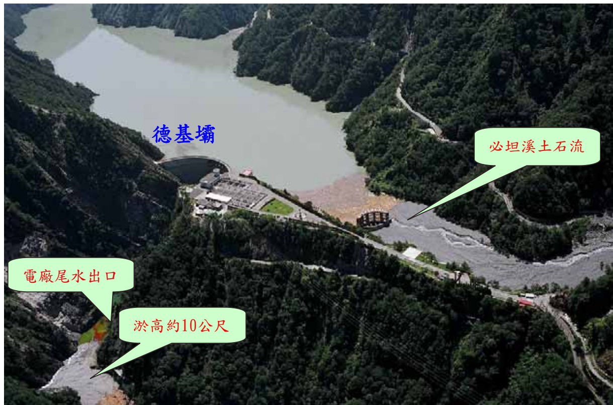
圖 2.5 德基分廠災損情形
