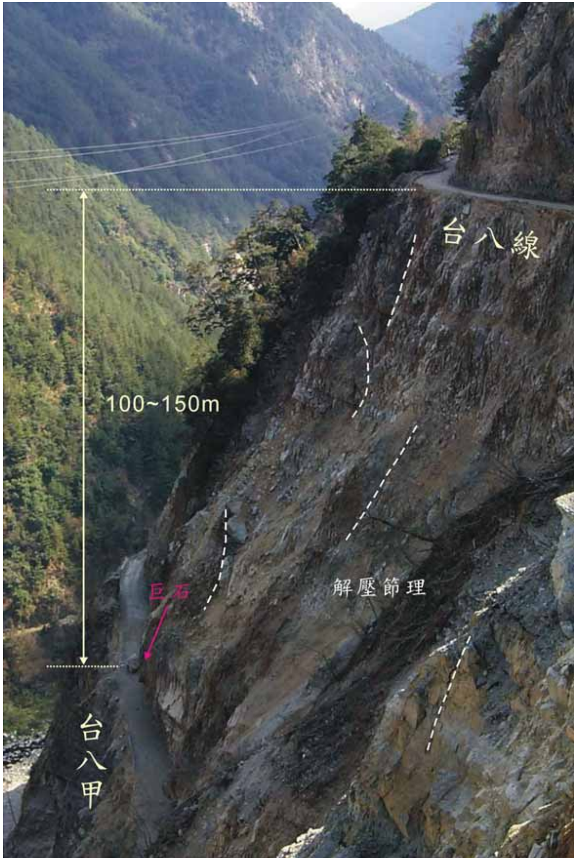
圖 2 光明橋附近台八上下線之解壓解理
