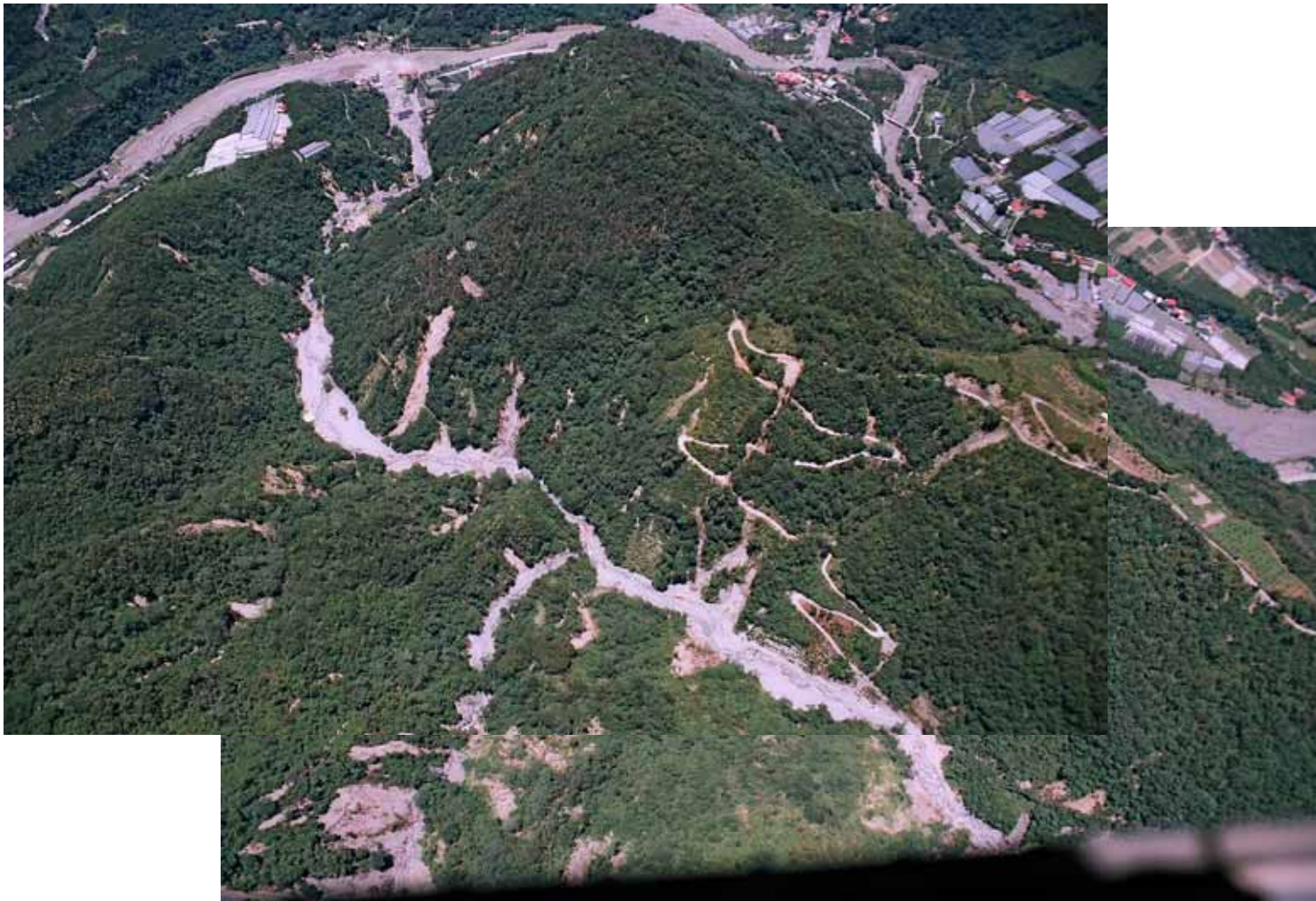
南投 A006(本部溪橋上游野溪)全貌，右岸之崩塌位置與道路相關性高。
