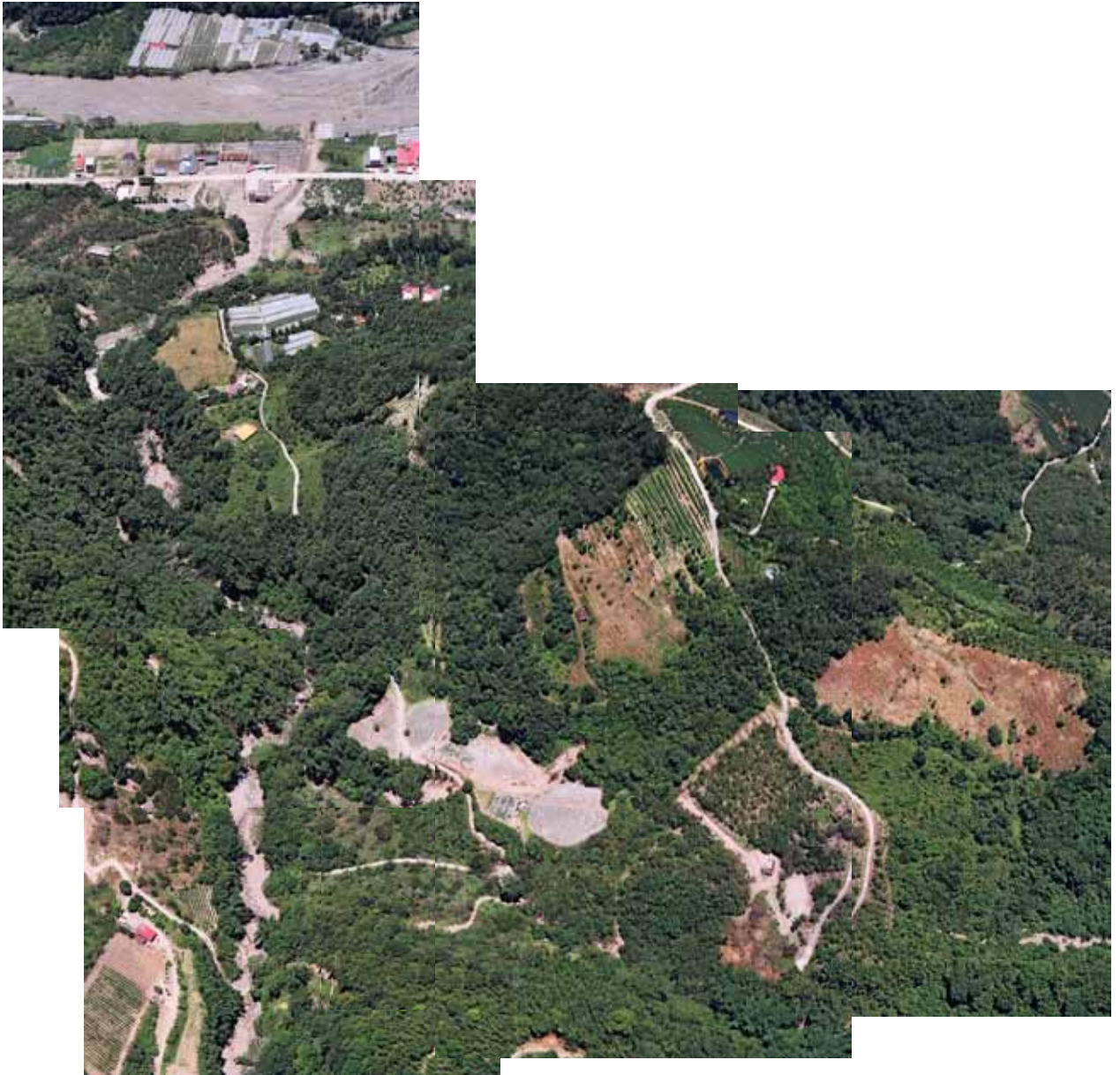
南投 004 土石流潛勢溪流中游溪溝中仍堆積有部分土石。
