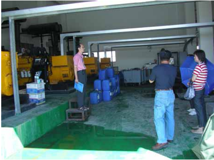
圖 2-7 勘災小組於台西村新山寮抽水站勘查
