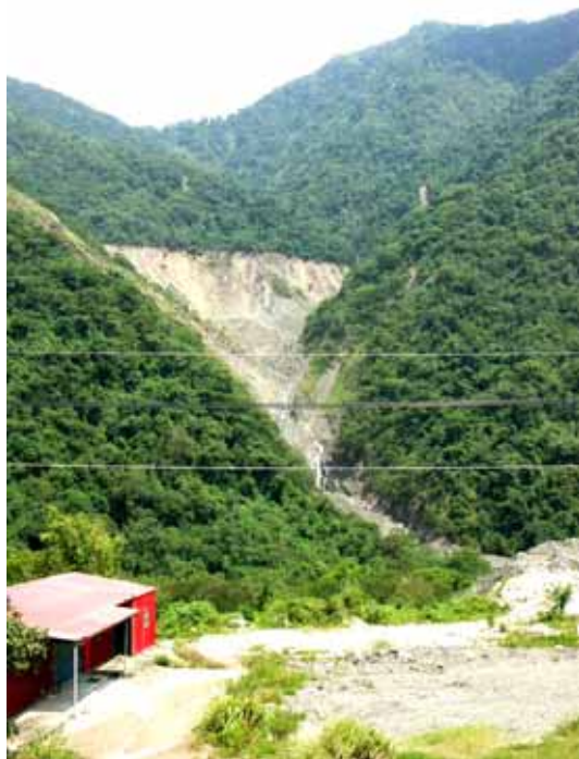
照片 66 S-05 災損情形(台 20 線塔拉拉魯夫隧道路段)
