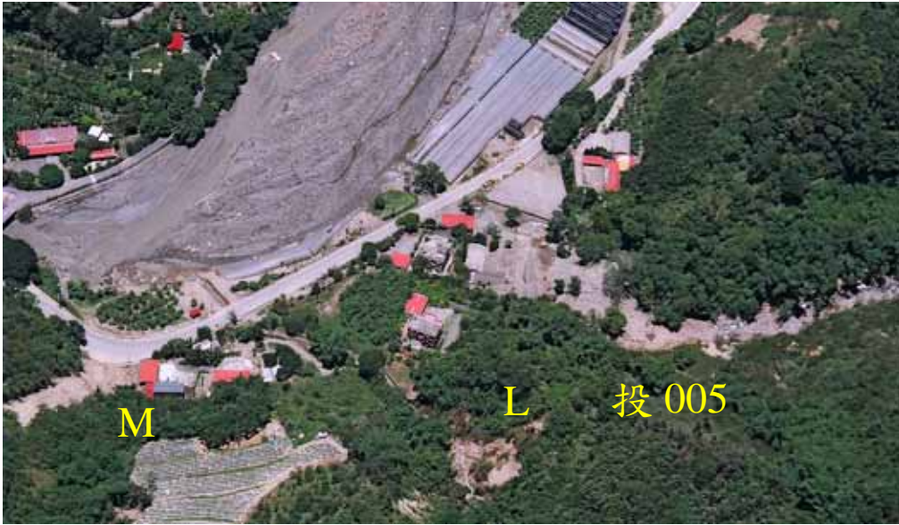
上圖標示 L,M 處之道路及保全對象受損情況。
