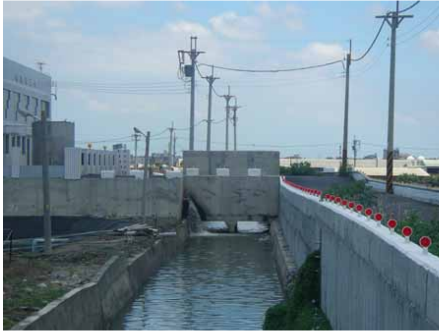
圖 2-23 口湖鄉蚵寮抽水站未設置於大排旁
