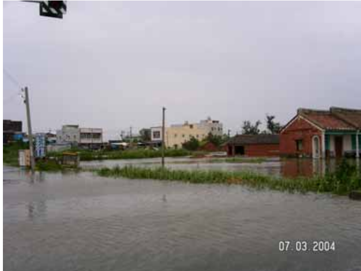
圖 2-60 台西鄉海口村淹水情形
