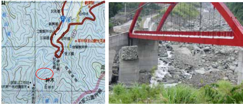
圖 2.25 左：神木吊橋平面位置圖；右：災害現況空拍照片
