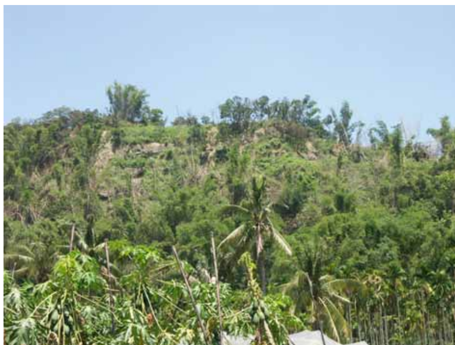
照片 2-91 S-22 災損情形(高雄 184 縣道 49K 處之西北方)
