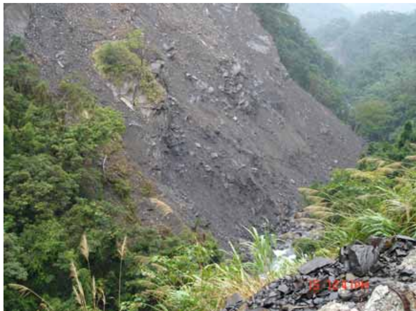
照片 2-74 S-09 災損情形(台 20 線 113k)
