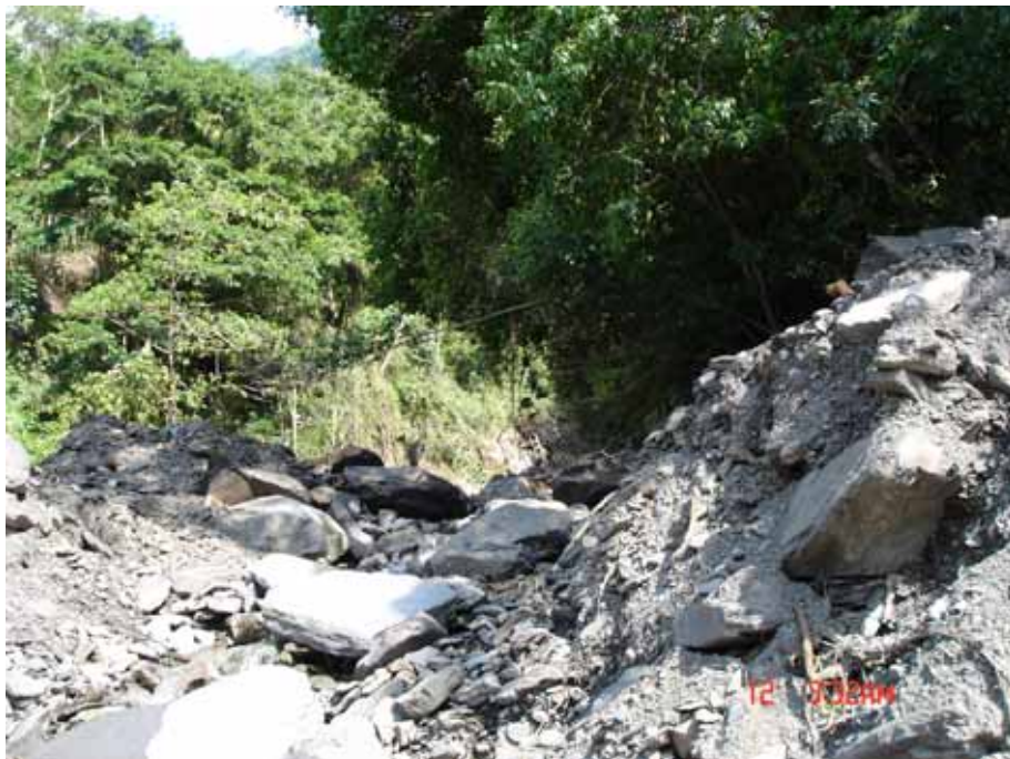
照片 2-72 S-08 災損情形(台 20 線 109k+50)
