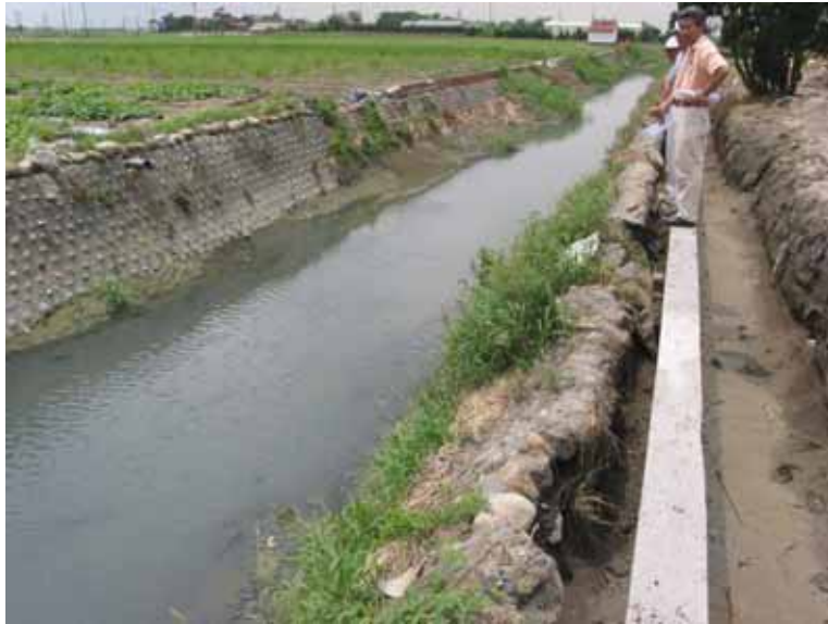
圖 2-64 東勢鄉有才寮大排至同安大排間
