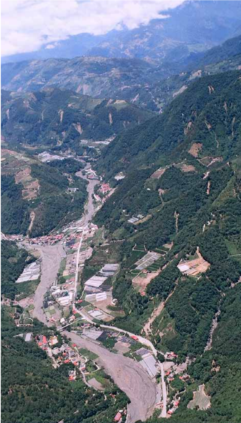
投 A001 土石流潛勢溪流(東露溪)，照片右側一系列山嶺主要由眉溪砂岩所構成。
