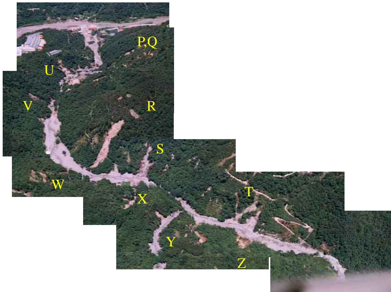
南投 A006(本部溪橋上游野溪)全貌，右岸之崩塌(P,Q,R,S,T)僅見於中、下游，左岸之崩塌數目遠超過右岸，且規模較大(如標示 Y 處之上游)。
