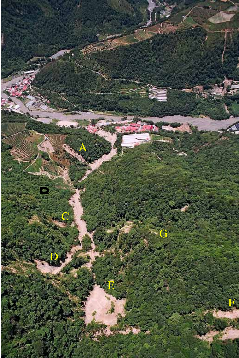
投 003 土石流潛勢溪流(下眉橋旁野溪)全貌，下游為南豐村 4 鄰(天主堂所在地)，野溪左岸開墾區清晰可見，照片左側上方為南山溪(南投 A002)。照片下方中央(E 處)源頭之崩塌坡面坡腳岩盤已出露，其上方另有多處崩塌(F 處)。左岸尚有兩處崩塌區(C 與 D 處)，其中左岸靠近源頭之崩塌(D 處)較為嚴重，然而崩塌面岩盤已出露，至於右岸崩塌(G 處)主要為坡頂崩塌下滑形成溝狀裸坡。開墾區邊坡下緣可見有兩處溝狀崩塌地(A 與 B 處)，崩塌型式似乎為沖蝕溝逐漸發展所引起。
