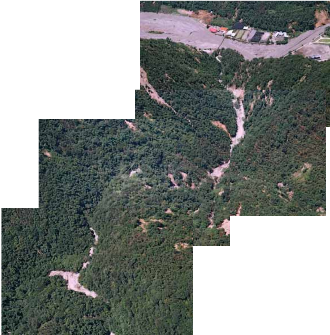
南投 A008 土石流潛勢溪流(觀音吊橋旁野溪)中游崩塌情況，觀音瀑布位於此一野溪中，根據地質調查所埔里圖幅說明書，達見砂岩出露於觀音瀑布。
