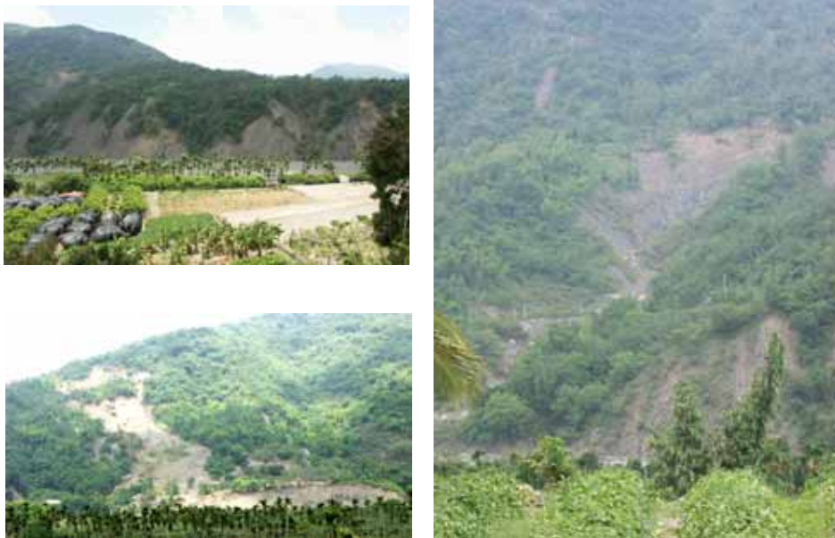
照片 2-83 S-17 災損情形(台 27 號公路 6K)
