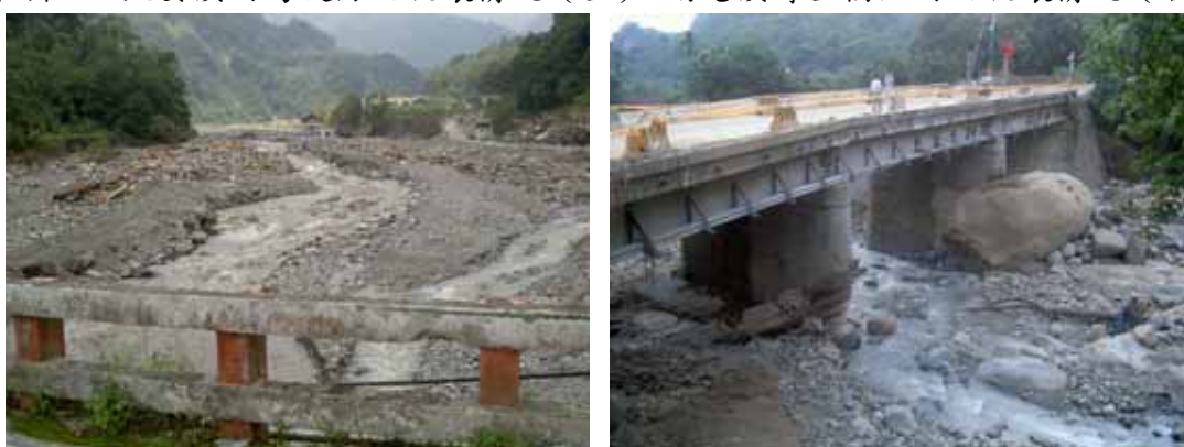
相片 42 風災過後河道滿佈浮木之情況（左），河道土石對中埔十橋之衝擊（右）
