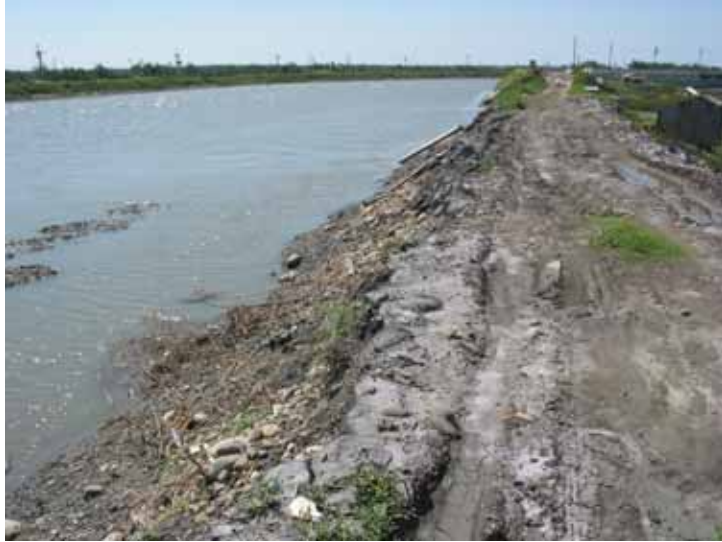
圖 2-50 舊虎尾溪北堤
