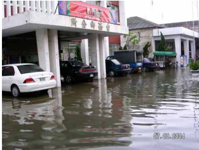
圖 2-56 台西鄉公所淹水情形
