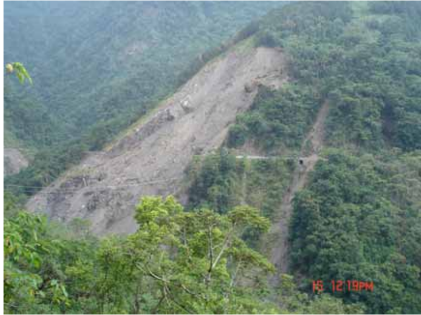
照片 2-73 S-09 災損情形(台 20 線 113k)
