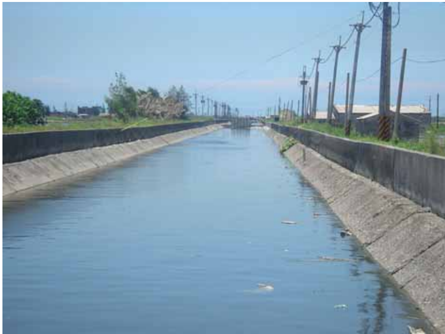
圖 2-25 口湖鄉 2 號路雨水下水道之出口匯流處大排
