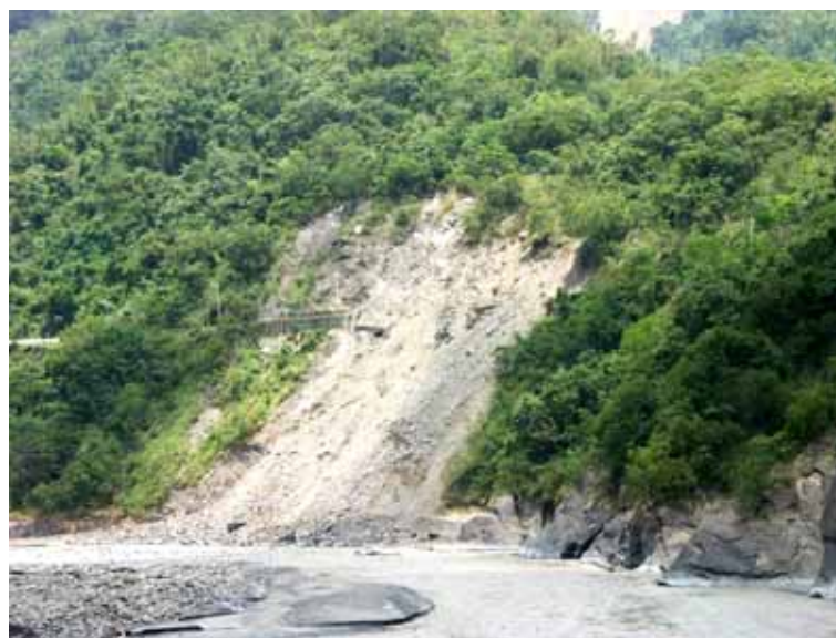
照片 2-61 S-01 災損情形(台 20 線寶來二號橋路段)
