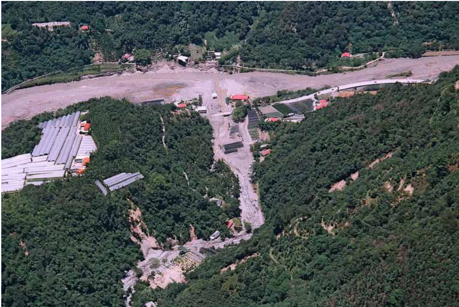
南投 A006(本部溪橋上游野溪)下游沖積扇，照片中隱約可見，眉溪於此稍微成一弧型轉彎，形成本部溪橋對岸之河岸沖刷，加上本部溪沖刷而下之土砂佔據河道，因此造成河岸側蝕問題更形嚴重，對岸民宅已因河岸側蝕造成基礎掏空而傾倒。
