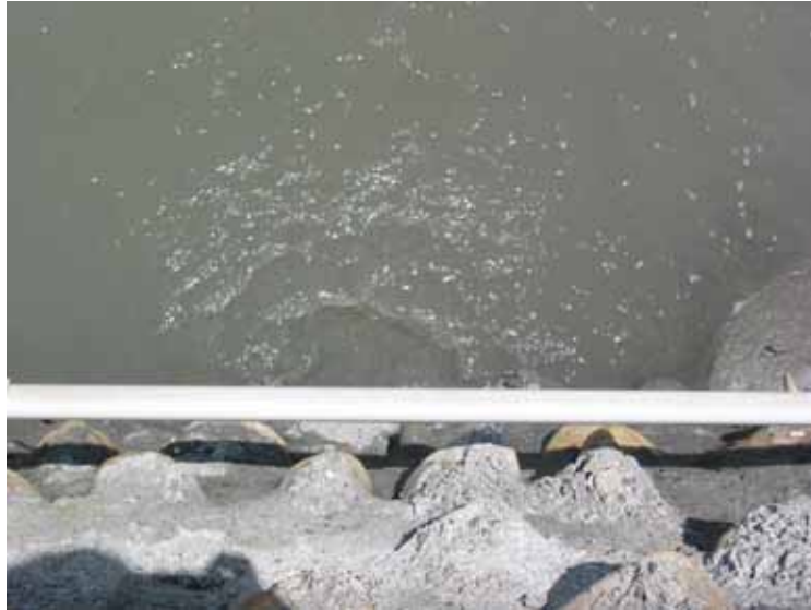
圖 2-48 新虎尾溪北岸防潮堤(2)
