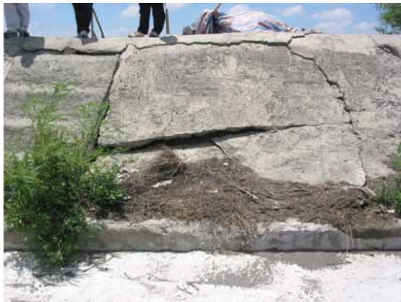
圖 2-47 新虎尾溪北岸防潮堤(1)
