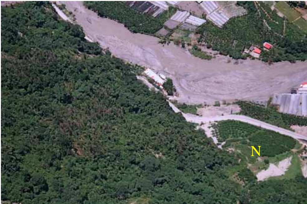
上圖標示 N 處之道路及保全對象受損情況。
