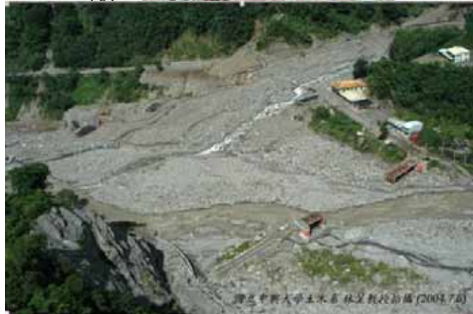
圖 2.23 上：愛玉橋平面位置圖；下：災害現況空拍照片
