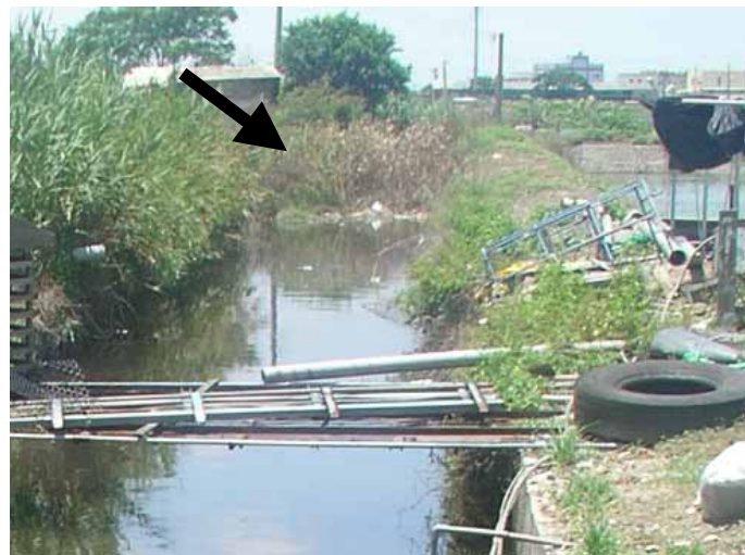
圖 2-21 往蚵寮排水明溝遭雜草阻塞已喪失排水功能
