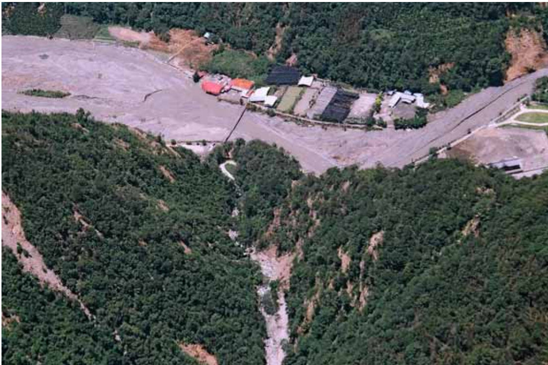
南投 A008 土石流潛勢溪流(觀音吊橋旁野溪)下游沖積扇，圖中跨眉溪之橋即為觀音吊橋，觀音吊橋下游因南投 A008 之土砂下移進入主河道，加上河道突然變寬，因此土砂於河道中嚴重淤積，並掩埋部份位於河階地之民宅。
