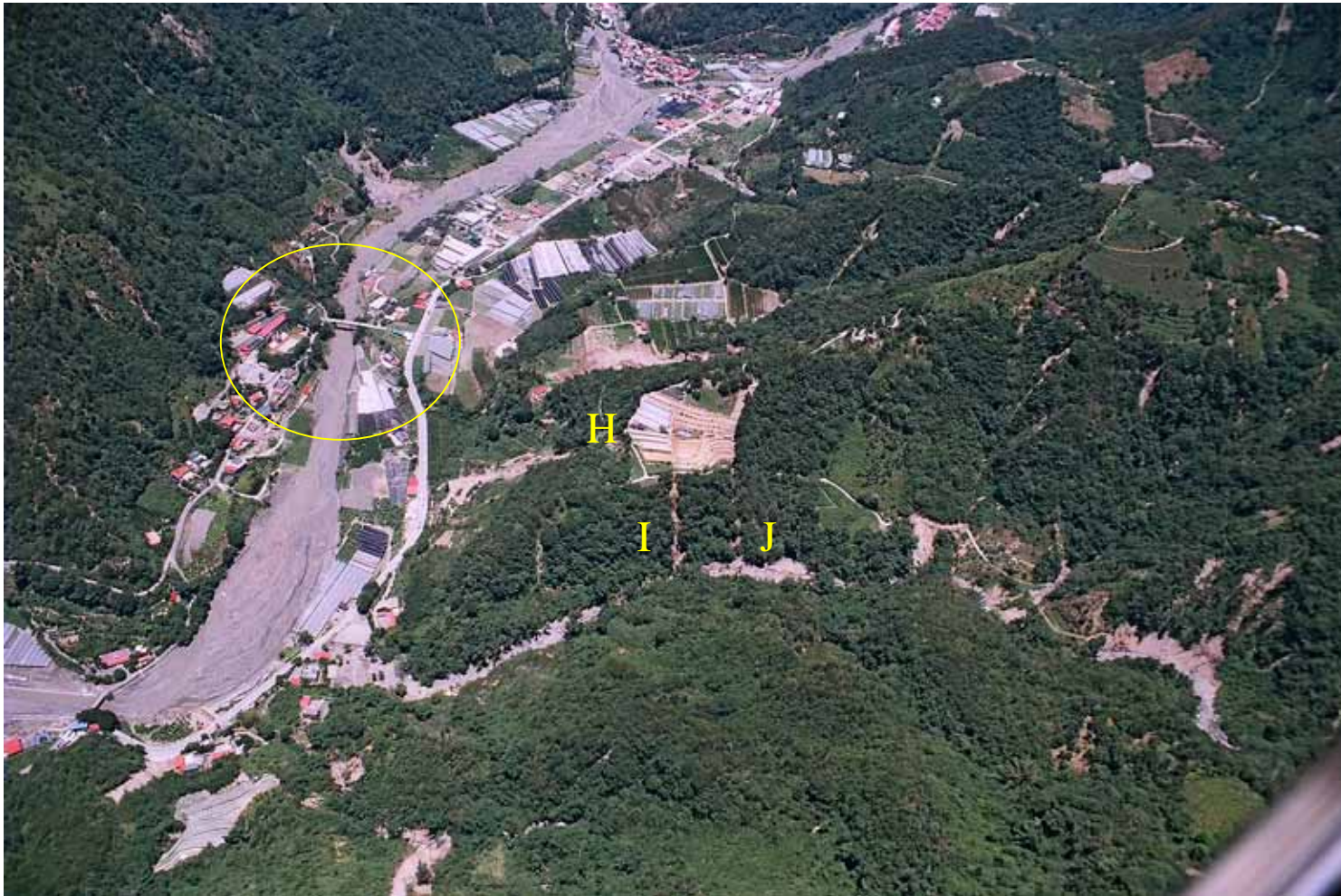
楓子林橋上方開墾區邊緣共有三處溝狀崩塌地，一處直接崩落至台 14 線(H 處)，兩處進入南投 005 野溪(I 與 J 處)，照片左側為同心橋，南豐國小操場清晰可見，其上方則為南投 A003 野溪。
