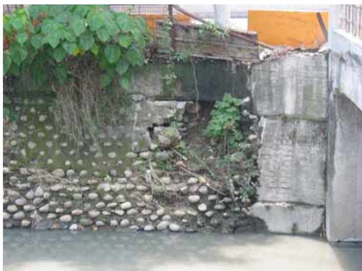
圖 2-71 斗六市雲林溪箱涵入口處上游護岸
