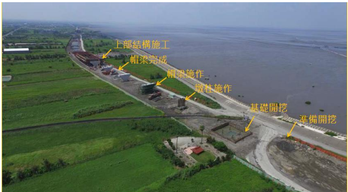
圖 5 創新作法-同墩之基礎、墩柱及帽梁須待整座橋墩灌漿完成
