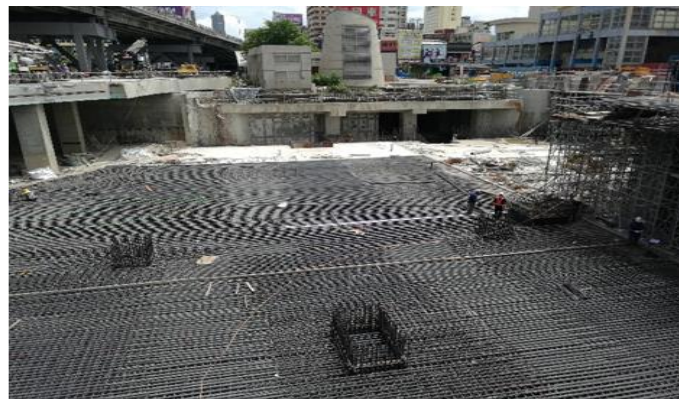
高雄車站鋼筋綁紮
