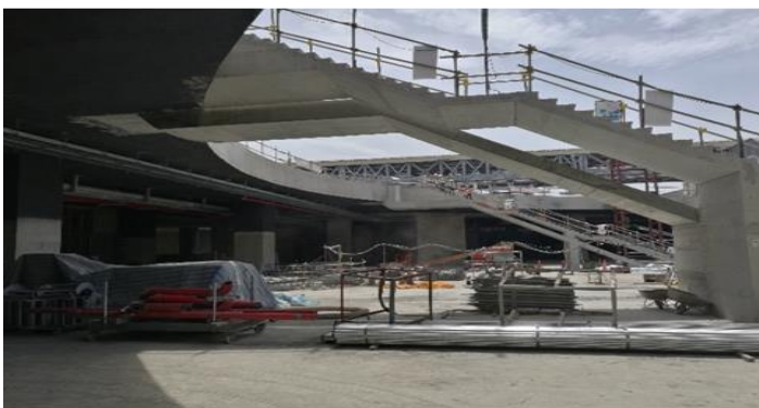
高雄車站穿堂結構
