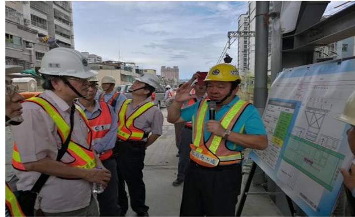
鳳山計畫要徑(青年路段隧道)
