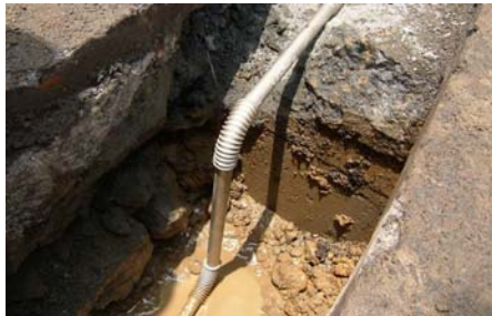
不銹鋼波狀管施工， 減少接頭施工，降低漏水
