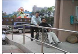
無障礙斜坡道一按愛心專人即前往服務(南區分處)
