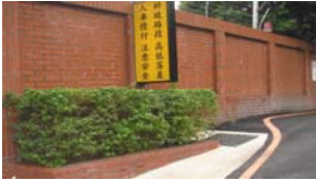
斜坡路面增設提醒警語(客服中心)
