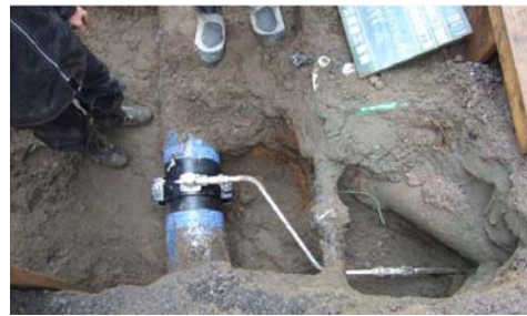
給水管施工穿越障礙物容易， 提高施工效率
