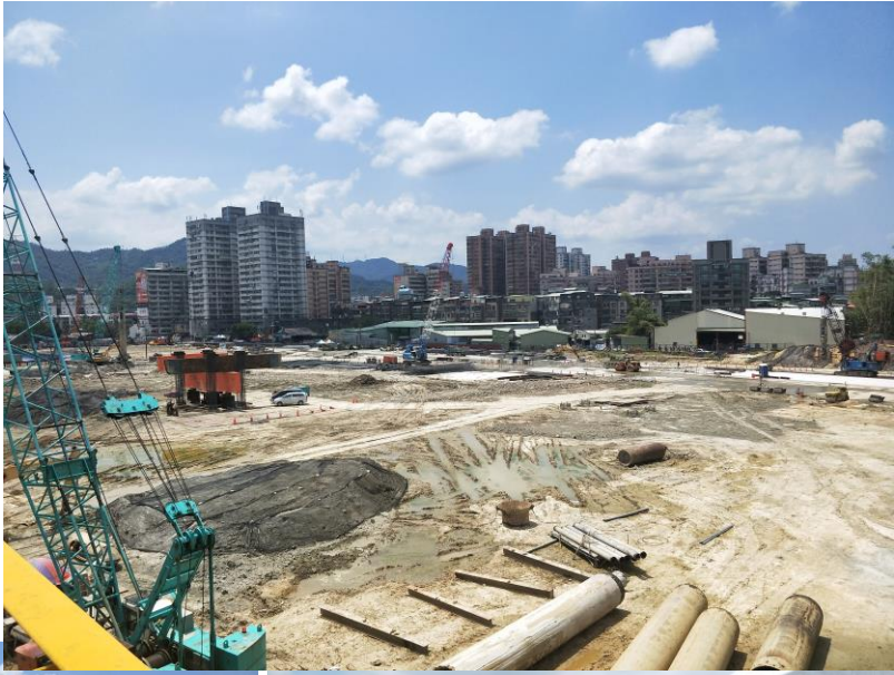
金城機廠 及莒光站 (LG08A) 施工現況
