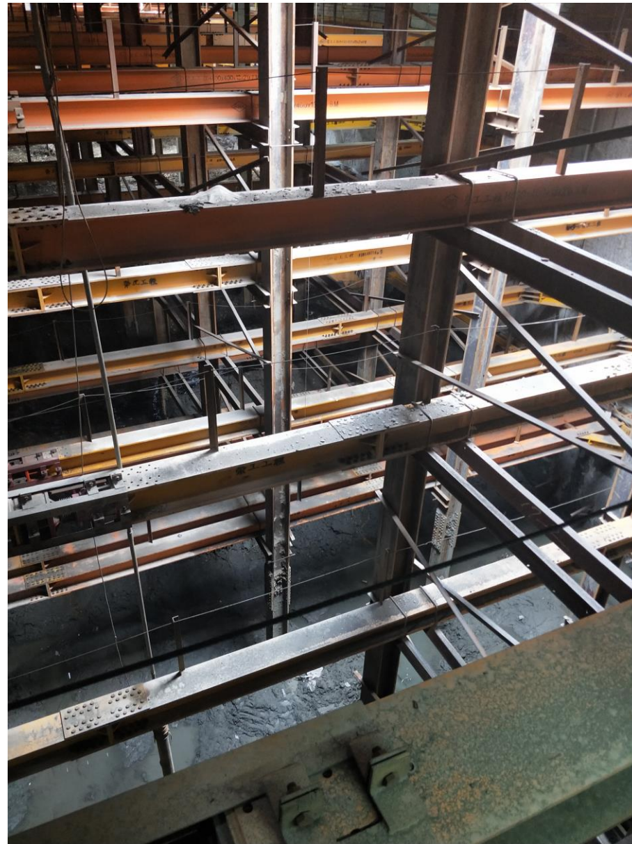
永和站 (LG05) 施工現況：站體結構已達 8 挖 7 撐 (共 9 挖 8 撐)
