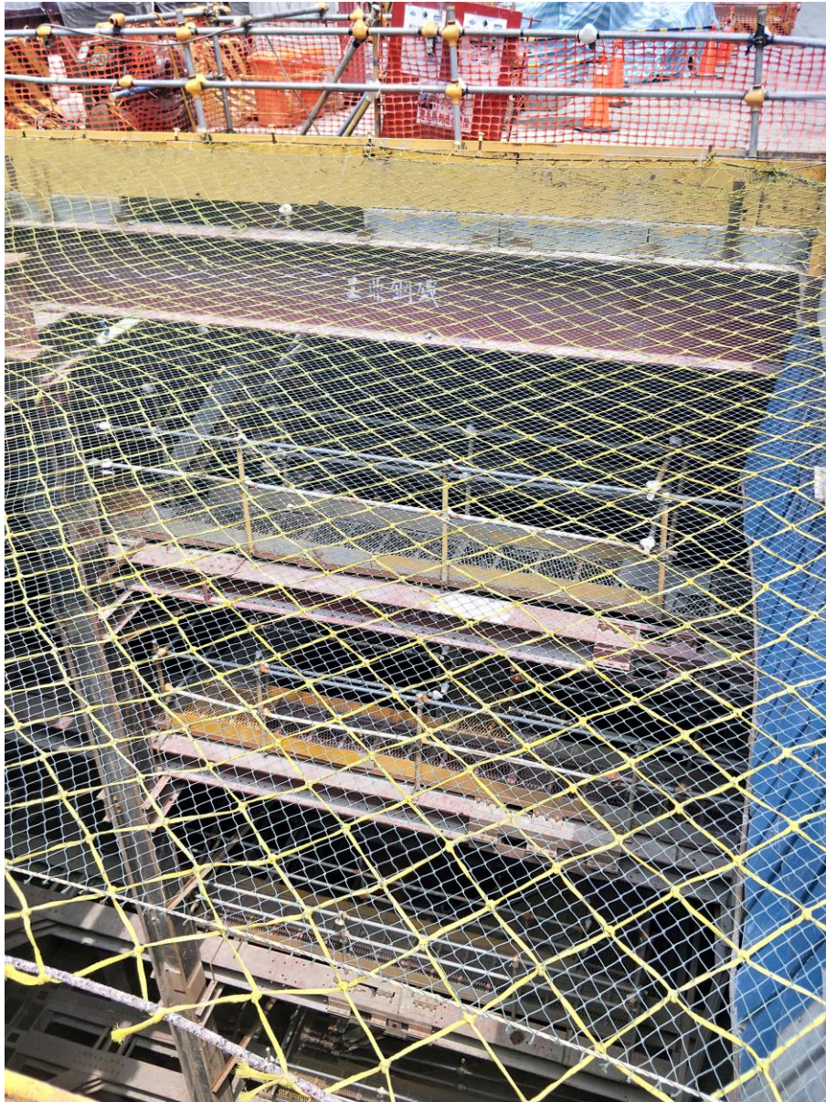
中和站 (LG06) 施工現況：站體開挖支撐與環狀線連通情形
