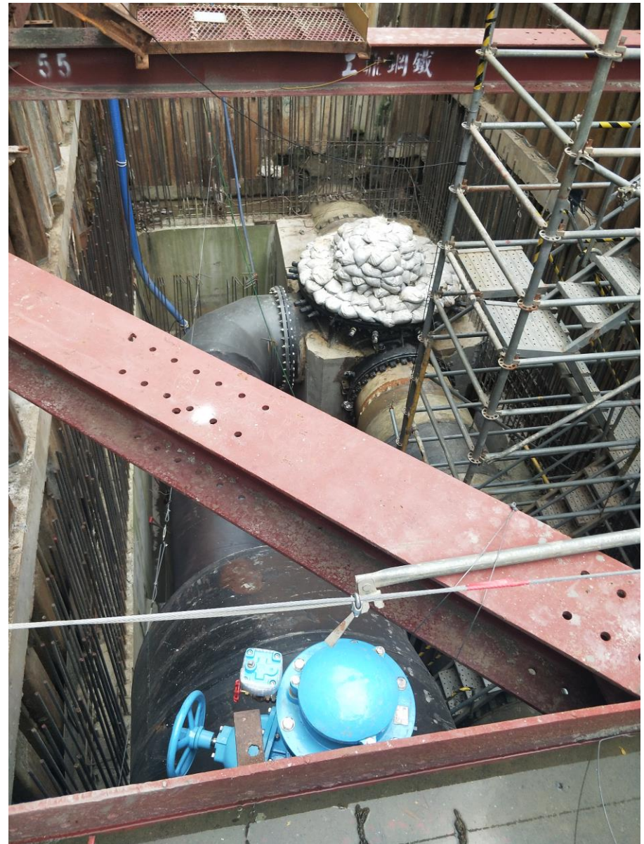
中正紀念堂站 (LG01) 施工現況：1650mm 臨遷鋼管不斷水特殊工法
