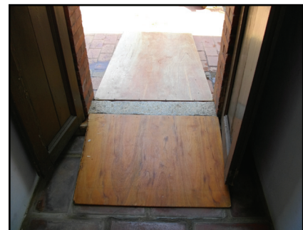
金水國小移動式木造斜坡
