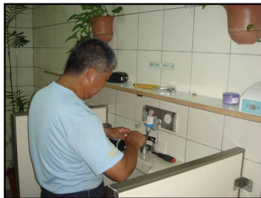
水電設備維修
