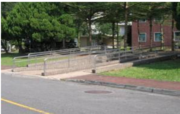
無障礙設施(斜坡道)
