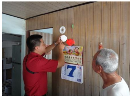
圖 98 安裝住宅用火災警報器
