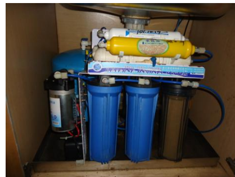
圖 32 飲水機之過濾系統
