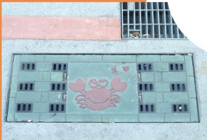
螃蟹造型溝蓋板
