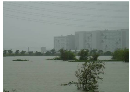
圖 10 台南園區滯洪池 B 蓄滿水
