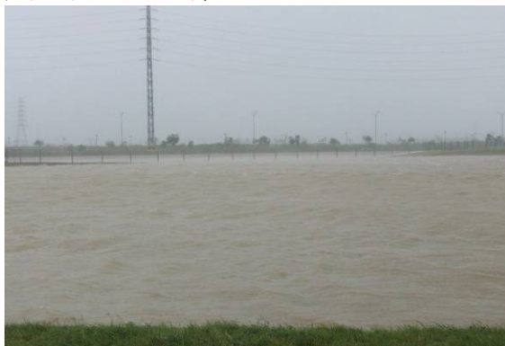
圖 9 高雄園區滯洪池蓄滿水
