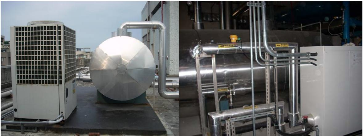
圖 142：水對水及空氣對水型式熱泵
