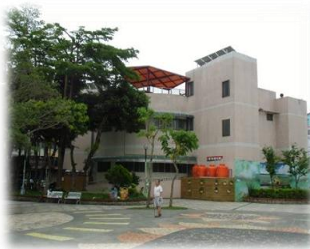
圖 74、三重區三德公園化身乾淨公園
