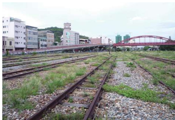
歷史鐵道設施－1,067mm 軌道
