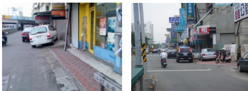
附圖 2.6 民權路至北興陸橋間住戶停車佔用人行道
