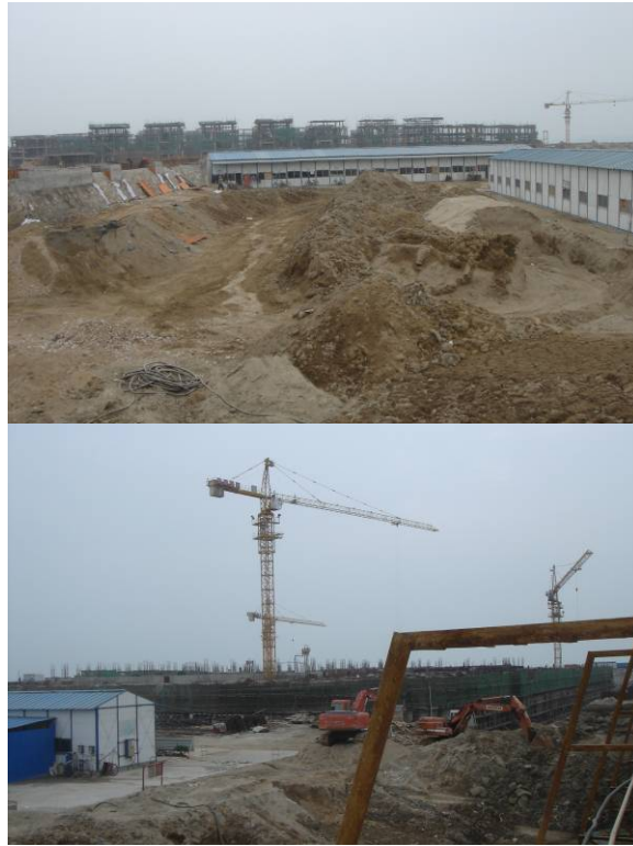
圖 10-3-4 香山國際遊艇俱樂部施工現況
