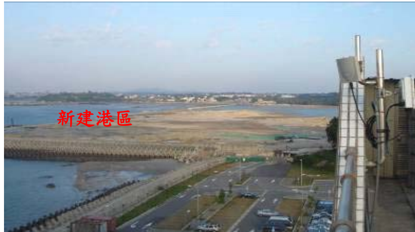
圖 10-2-5 水頭港新建港區現況
