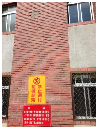
圖5-2-1 臺東縣政府文化處圖書館外牆磁磚剝落實景
