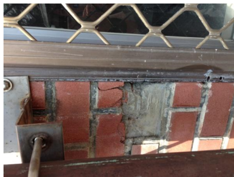
圖5-2-1 臺東縣政府文化處圖書館外牆磁磚剝落實景
