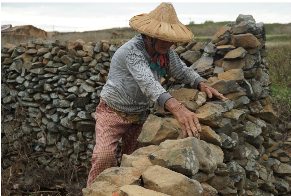
圖 4 居民就地取材以玄武岩砌石成為石牆、住屋建材，但現在老成凋零，砌牆工法已即將消失
