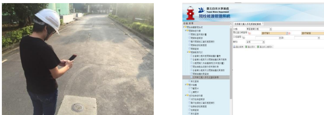
圖 1：閘栓現場巡檢，系統同步現場上傳資料
