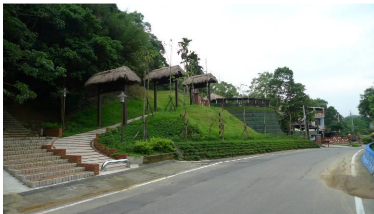
圖片說明：茶香山歌古道飄-造橋鄉大西聚落客家文化生活環境營造第二期工程
