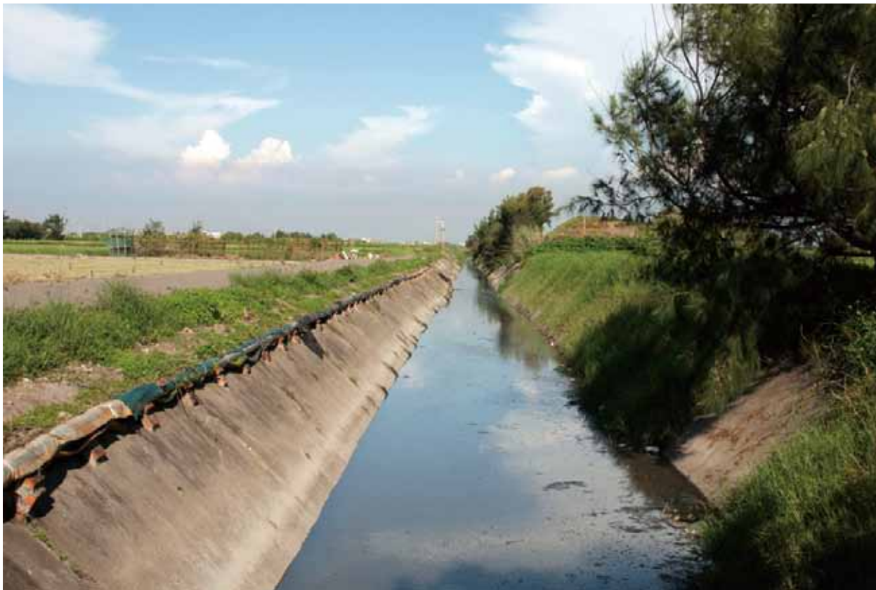
改善農田水利設施，提升農業用水效益
