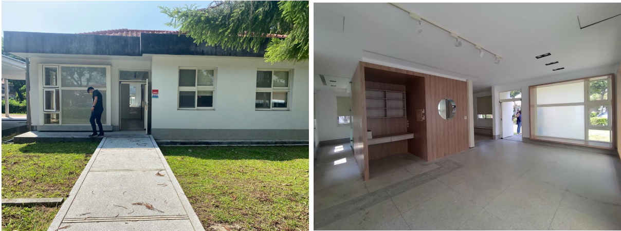
圖56 位於光明一路 36 號現況環境與室內空間概況
