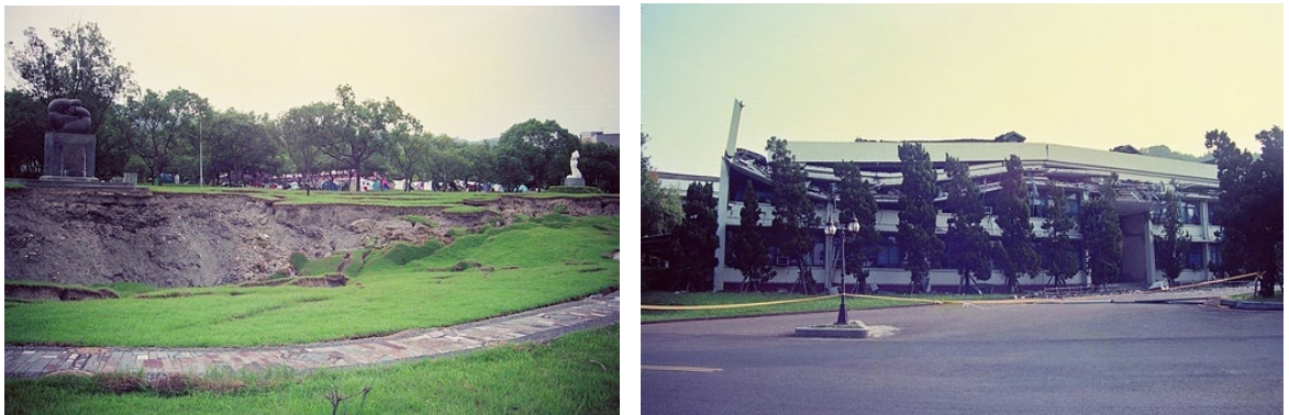
圖8 921 大地震造成中興新村出現嚴重的斷層陷落及廳舍塌毀
