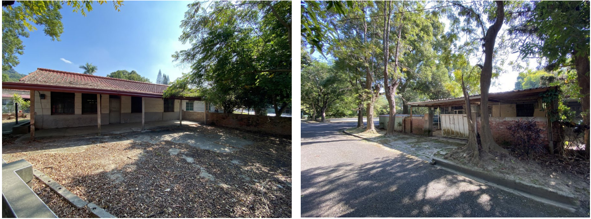
圖59 位於長春公園附近閒置宿舍外觀環境概況
